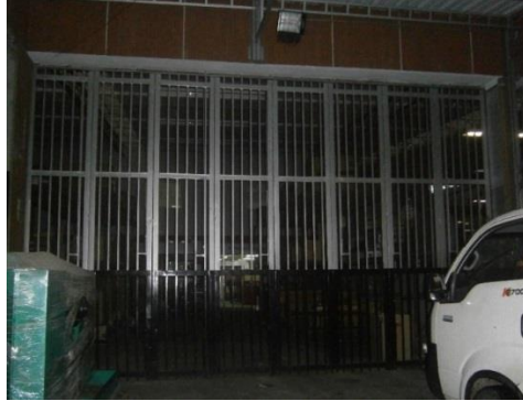
Figura 52. Almacén de repuestos
