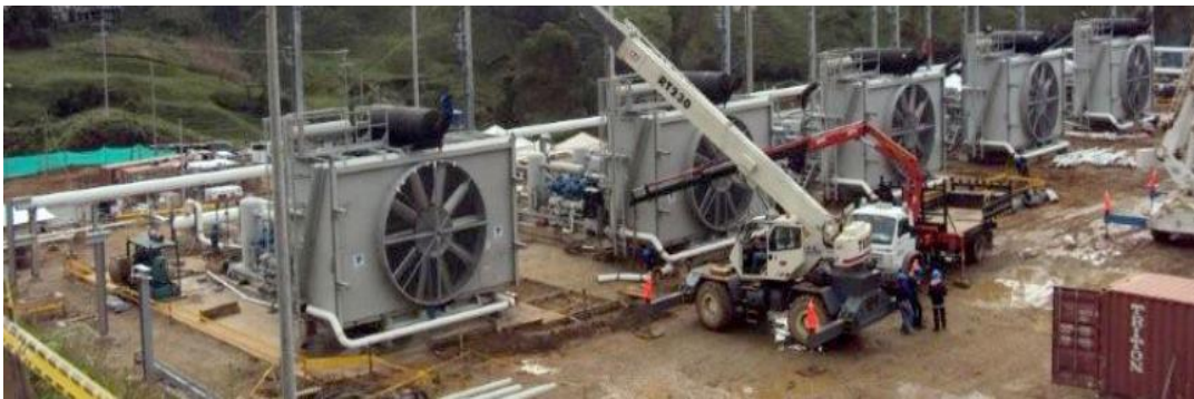
Figura 2. Construcción estación compresora
