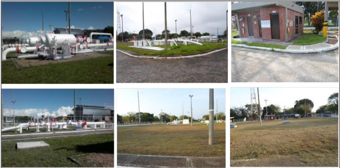
Figura 4. Instalaciones Operativas de TGI, Centro Operacional de Mariquita.
