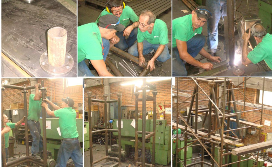
Figura 80. Fotografía del montaje de la estructura.
