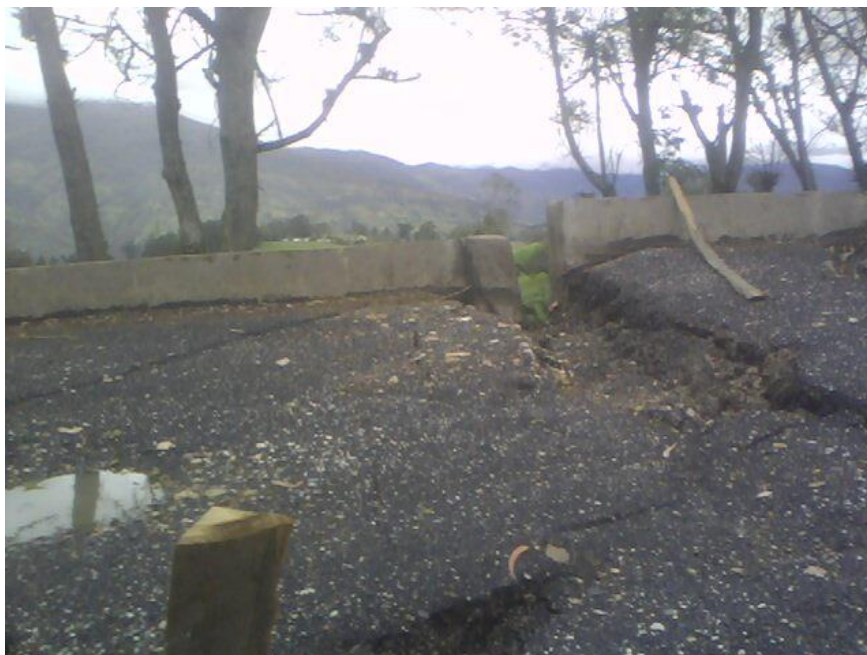
Foto 5: Detalle hundimiento
