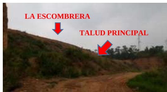
Figura 9. Talud principal de “La Escombrera”.
