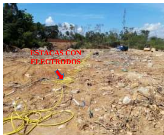
Figura 18. Montaje de la línea de tomografía eléctrica.
