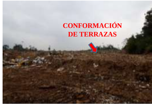
Figura 10. Formación de terrazas al momento de compactar residuos en campo.
