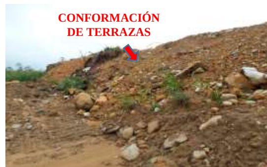
Figura 11. Formación de terrazas al momento de compactar residuos en campo.
