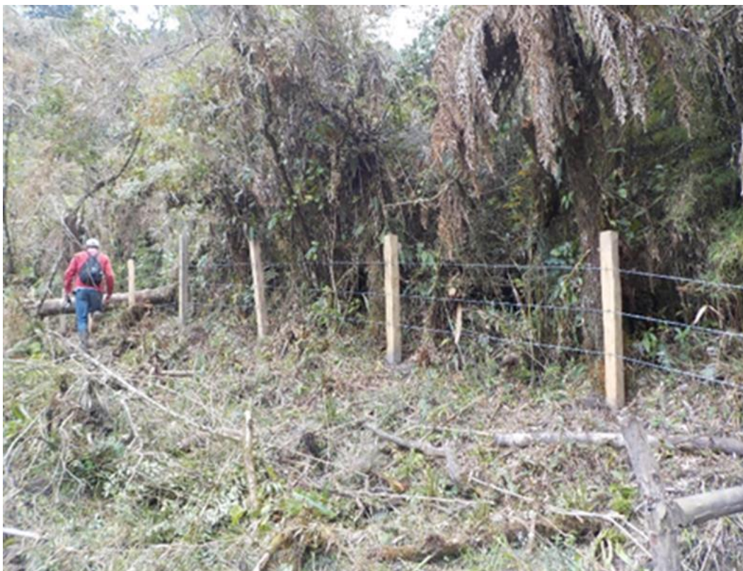
Apéndice 30. Tramo 6 vereda el Volcán 333 metros de cerca, 135 estantillos instalados.
