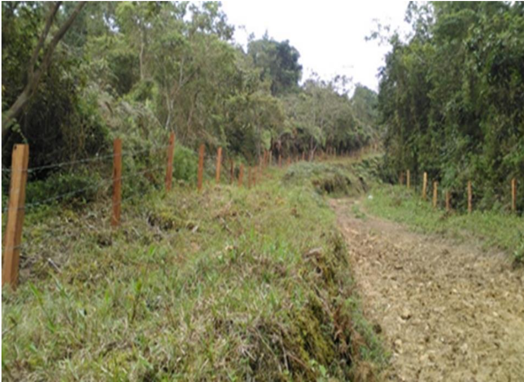
Apéndice 22. Tramo 6 vereda Toledito 725 metros de cerca, 310 estantillos instalados.
