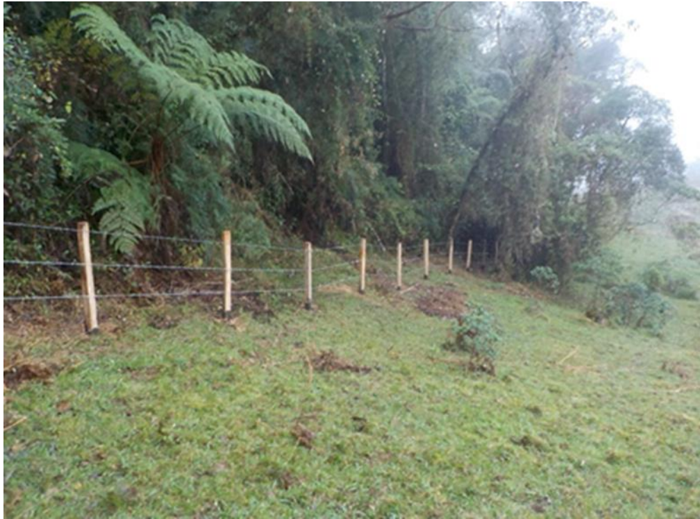
Apéndice 20. Tramo 4 vereda Toledito 584 metros de cerca, 246 estantillos instalados.
