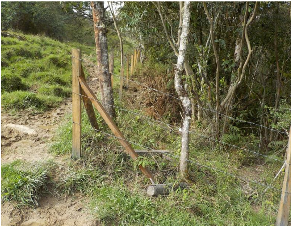
Apéndice 10. Estantillos instalados en cambios de dirección de la cerca.
