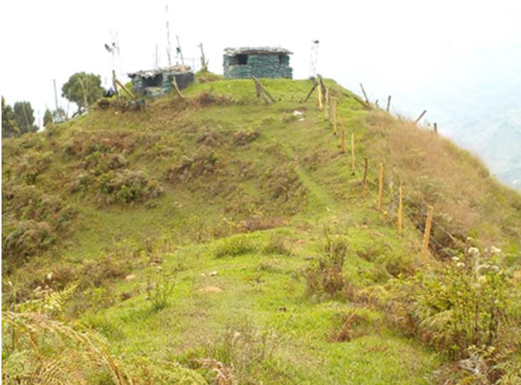
Apéndice 24. Tramo 8 vereda Toledito 146 metros de cerca, 60 estantillos instalados.
