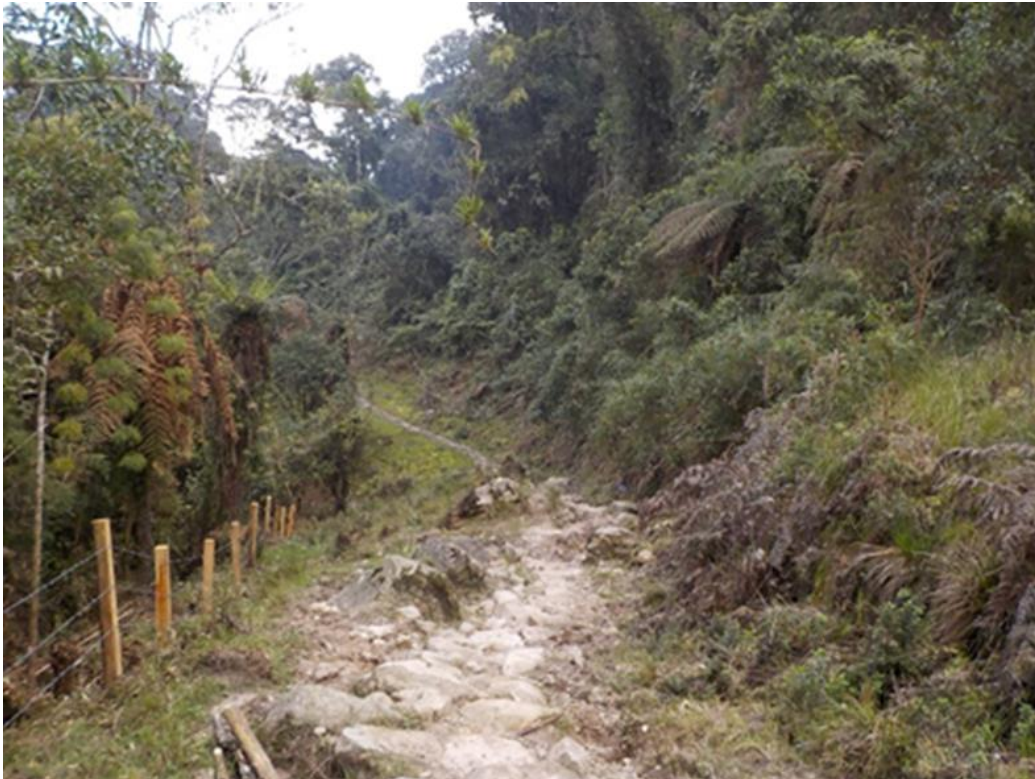
Apéndice 32. Tramo 8 vereda Salto del Venado 224 metros de cerca, 93 estantillos instalados.
