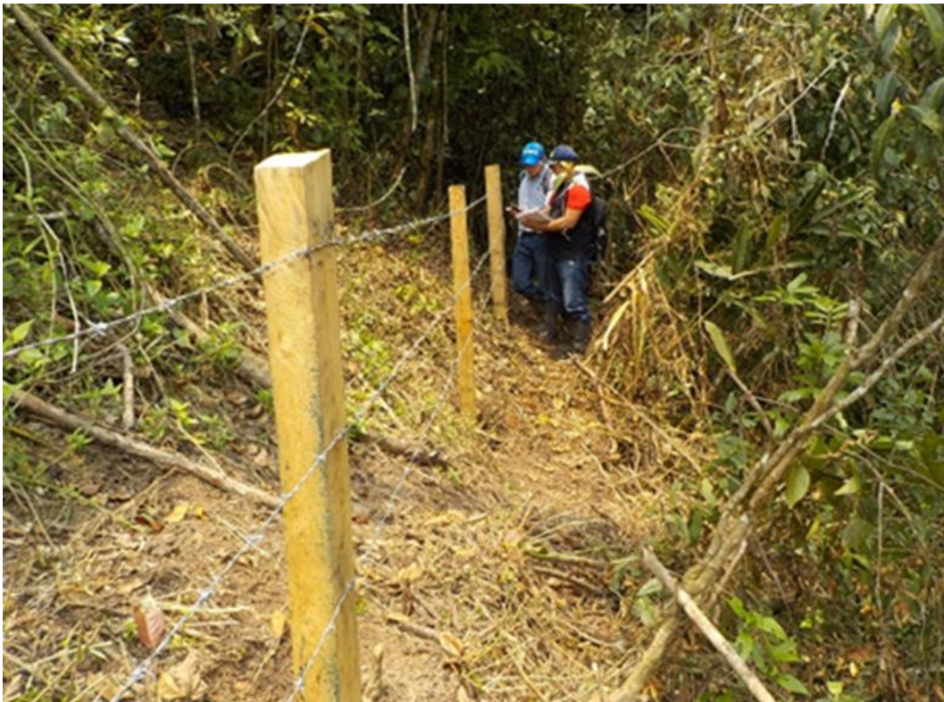
Apéndice 22. Tramo 6 vereda Toledito 725 metros de cerca, 310 estantillos instalados.
