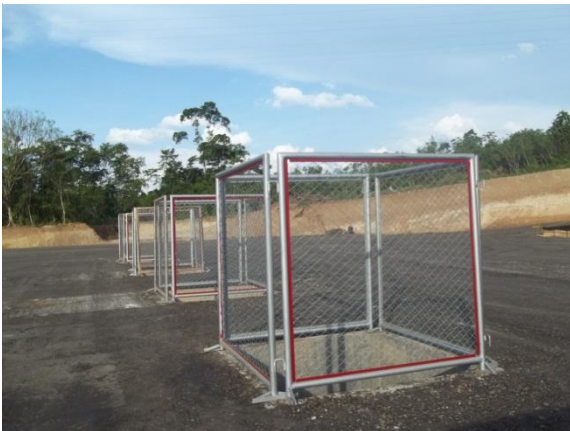
Figura 2. Cerramiento en malla galvanizada
