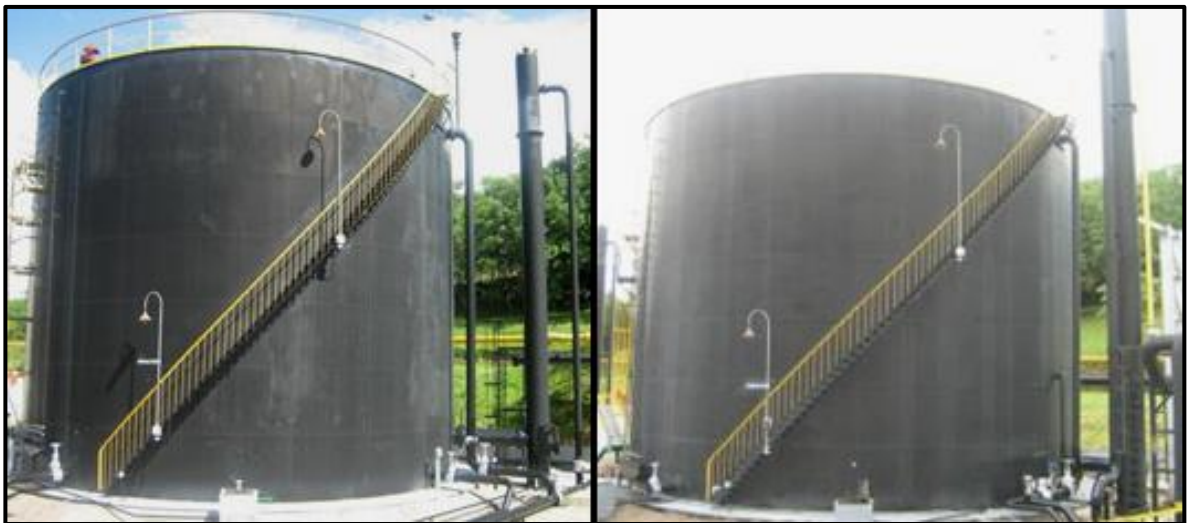
Fotografía 5. Bota de Gas (M-ABD-101/102) y Gun Barrels (M-ABK-101/102)
