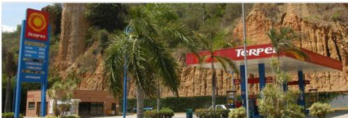
Figura 1. Estación de Servicio Estoraques.
