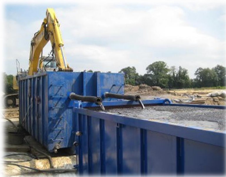
Fotografía 7. Lavado de suelos contaminados
