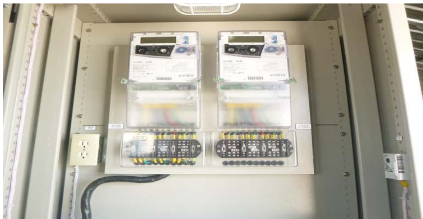
Fotografía 8. Contadores de energía.
