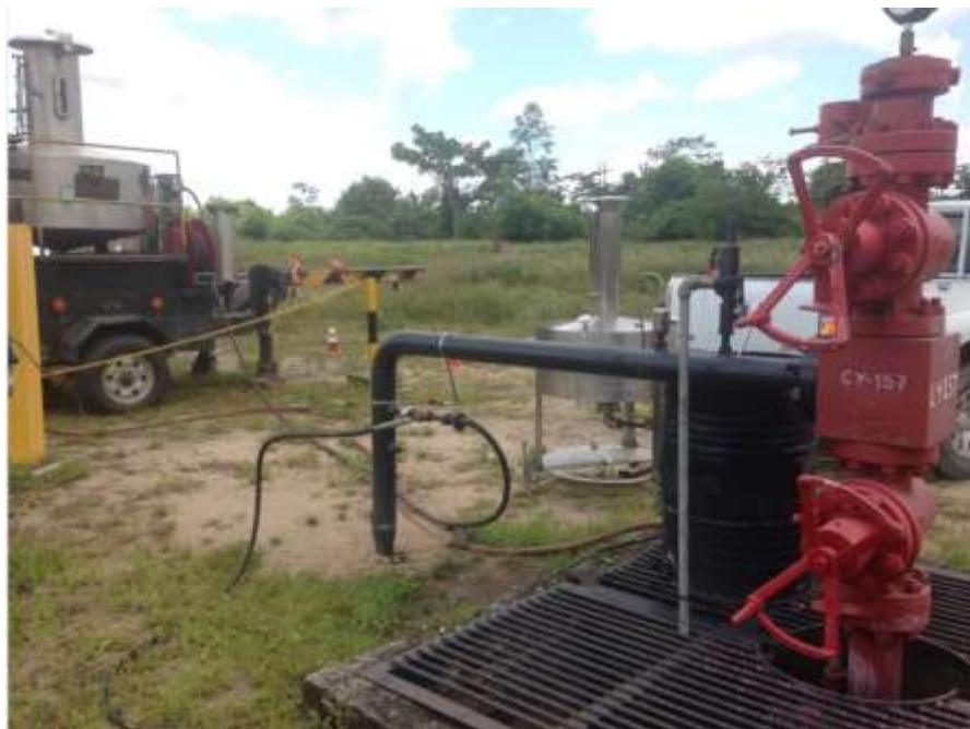
Fotografía 6. Pozo LY-157, Prueba comparativa de los tanques de prueba de 50 galones y el de 420 galones.
