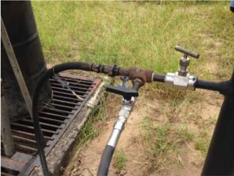
Fotografía 9. Primer plano de conexión típica, realizada en cabeza de pozo.
