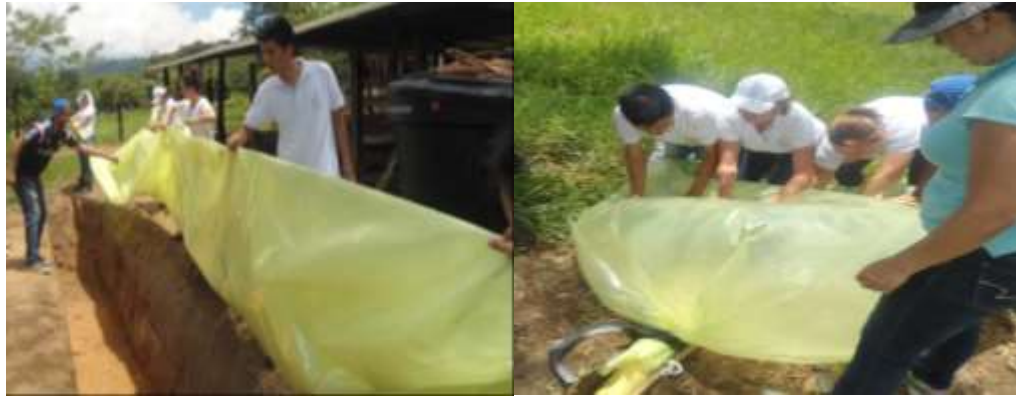
Ubicación del biodigestor en la zanja. Llenado de aire del biodigestor.
