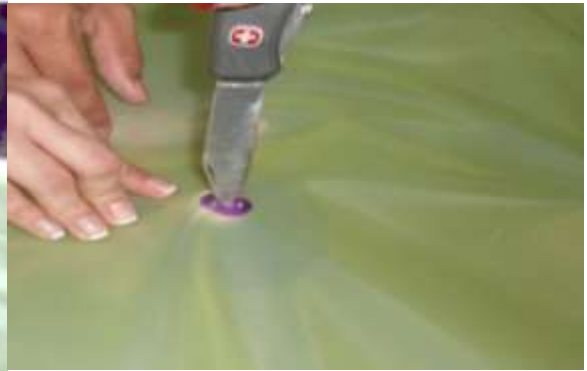
Abertura de salida del biogás
