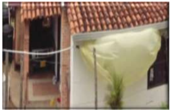
Reservorio de biogás
