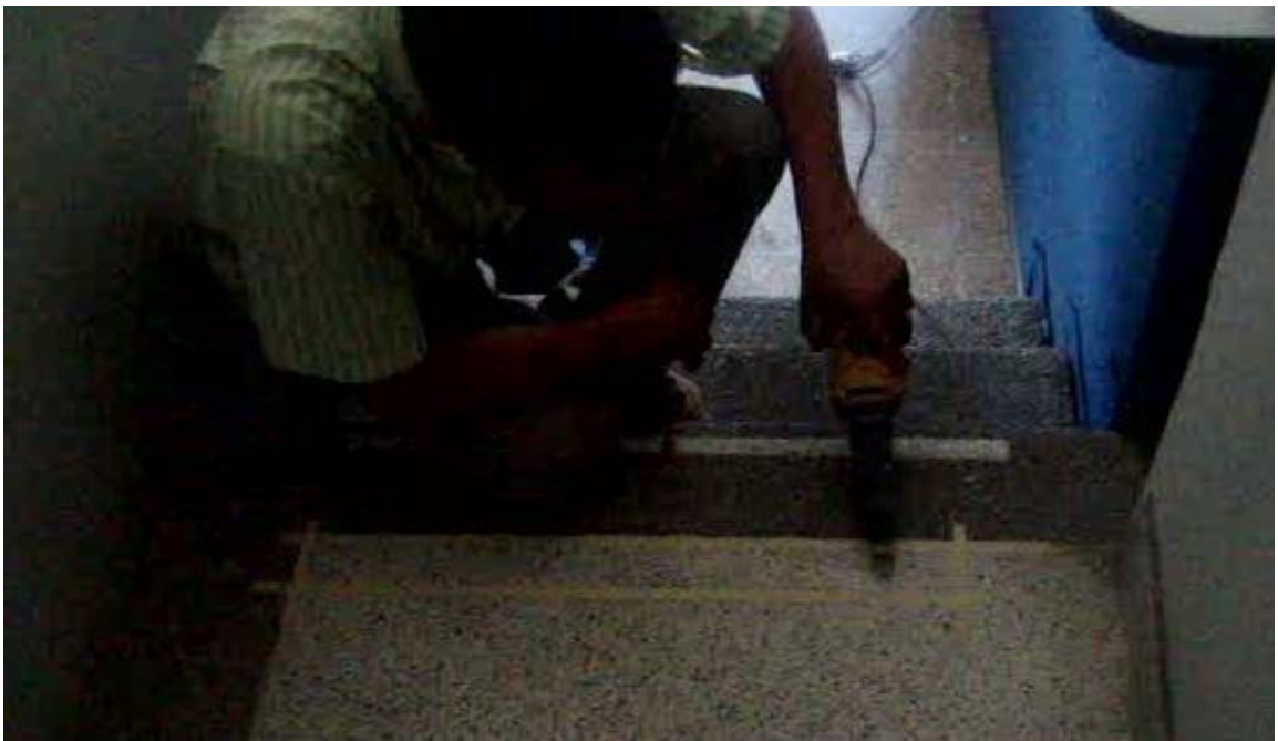
Figura 3. Proceso manual de remoción de esmalte
