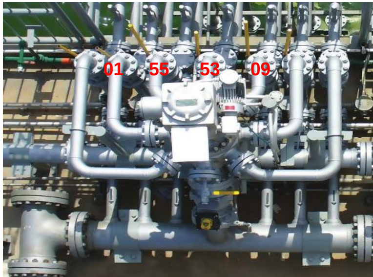
Figura 17. Imagen que representaría la configuración de la Válvula Selectora Multipuerto para el clúster 10
