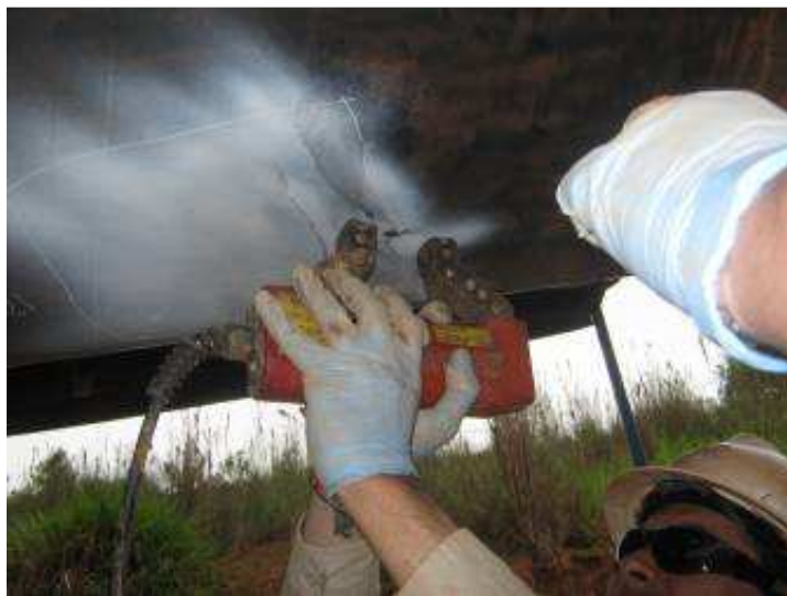
Ilustración 9. Inspección por Partículas Magnéticas en Abolladuras
