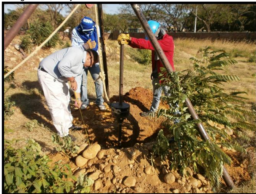
Figura 1. Ensayo Penetración Estándar, Barrio San Fernando
