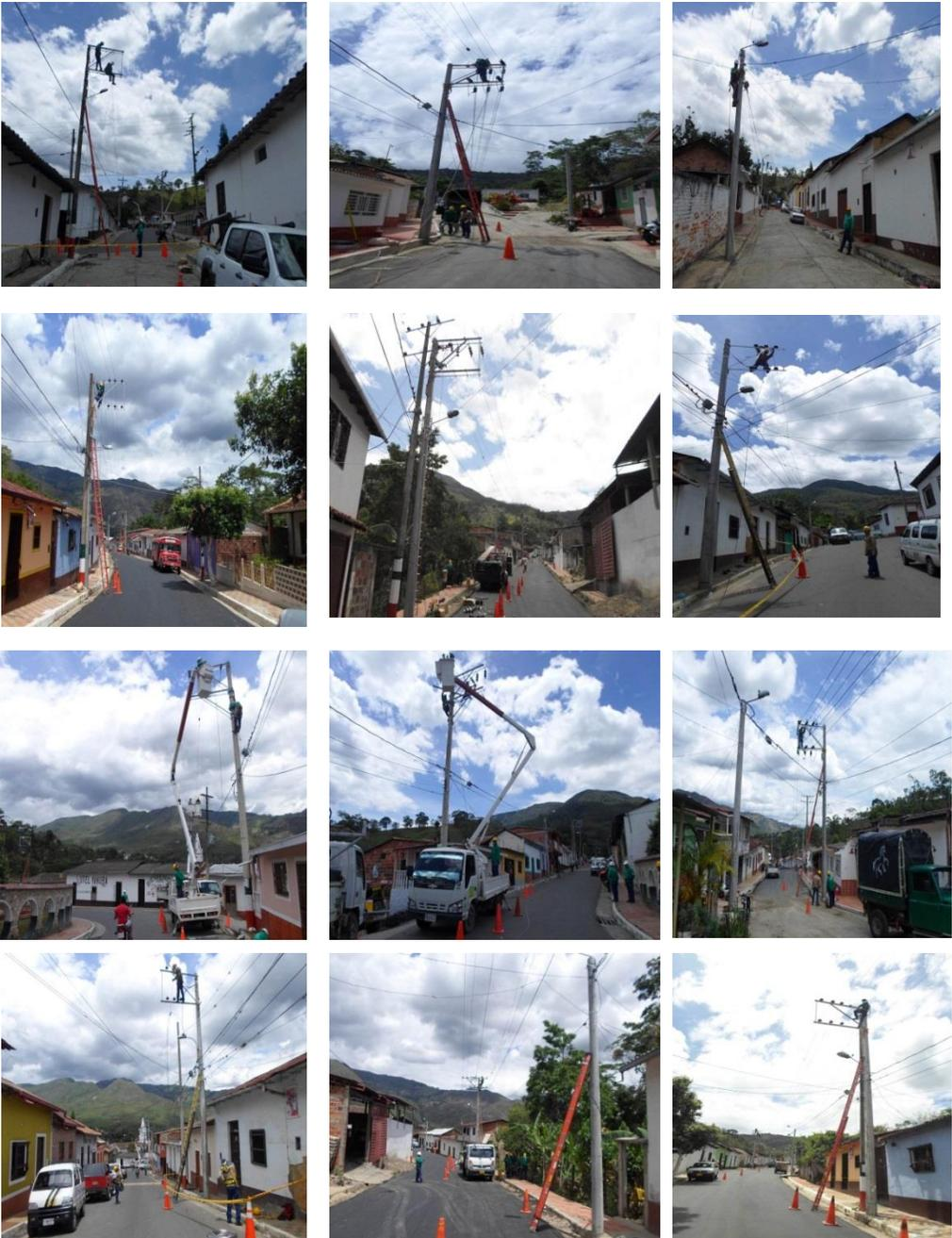
Las imágenes de la figura 44 muestran la remodelación de redes de media tensión de cable ASCR desnudo a cable ecológico y la independización con doble feeder del sector urbano y rural del municipio de Durania identificado como circuito 1T03996-1T03995.
