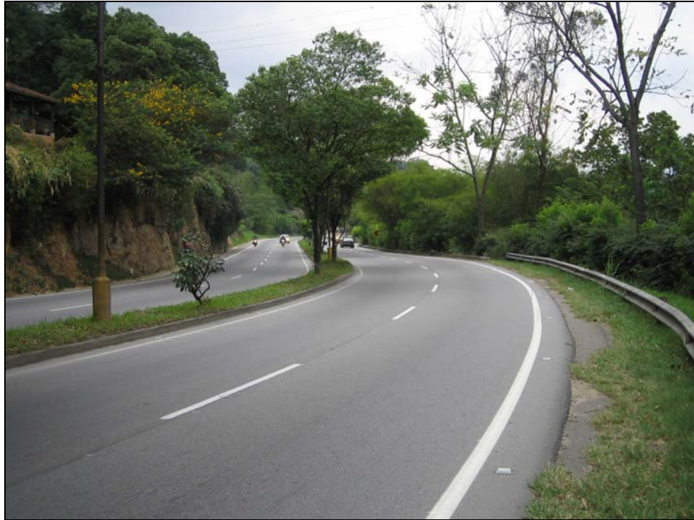
Figura 3. Condiciones de la Vía Antes de las Obras
