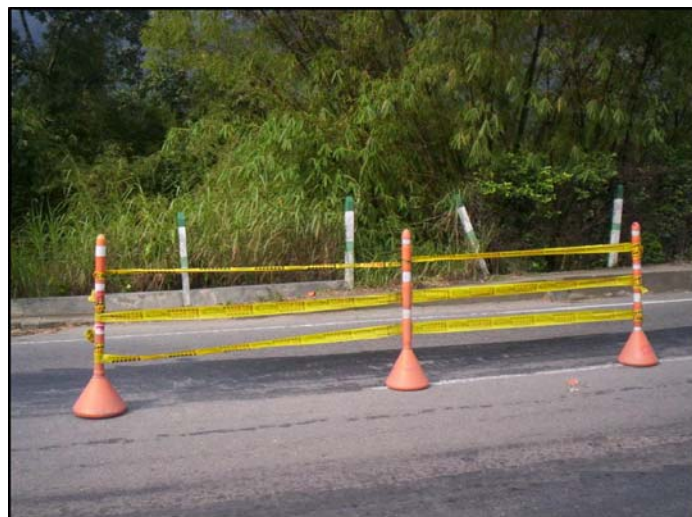
Figura 19. Delineadores Tubulares en obra
