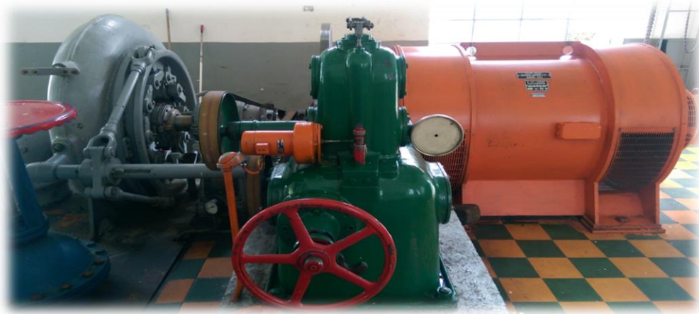
Figura 8. Generador Francis micro central La Pita
