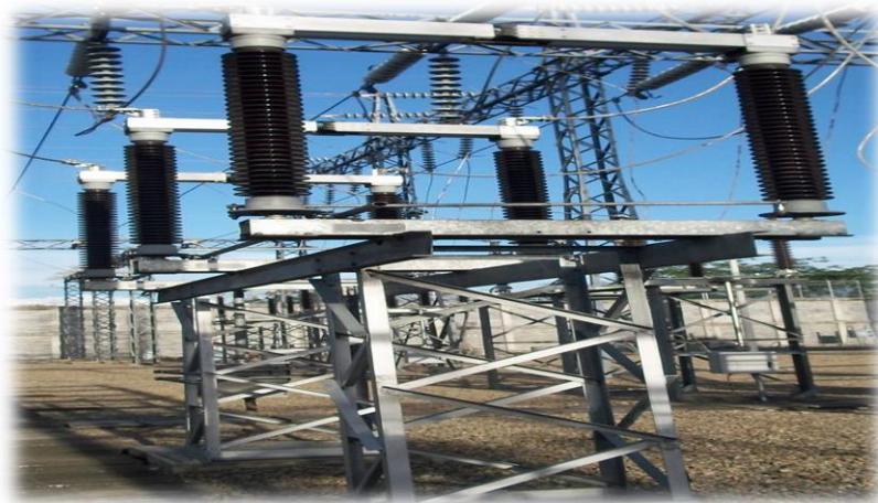
Figura 11. Seccionador tripolar de barras
