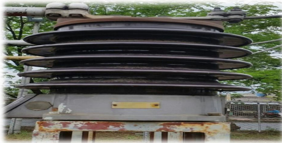
Figura 14. Transformador de medida corriente CT
