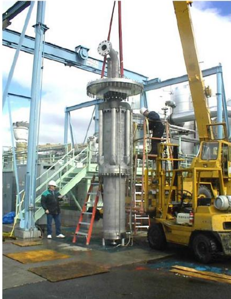
Figura 8. Bomba sumergible de GNL.
