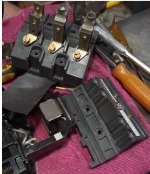
Figura 14. Desmontaje de arrancador de la bomba.
