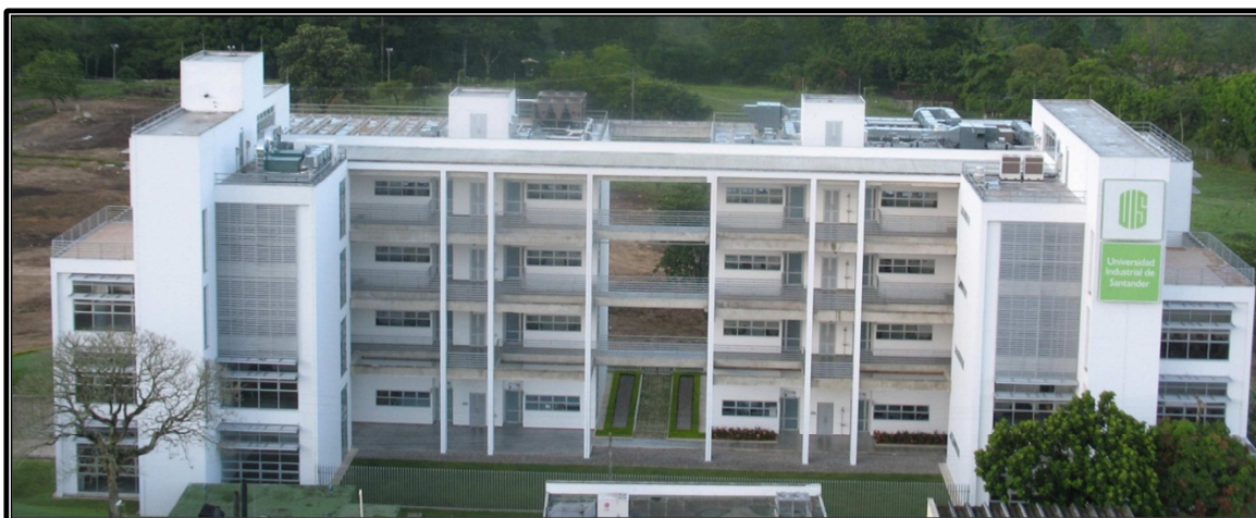
Figura No. 5. Área ya desarrollada, edificio de Investigaciones, PTG.
