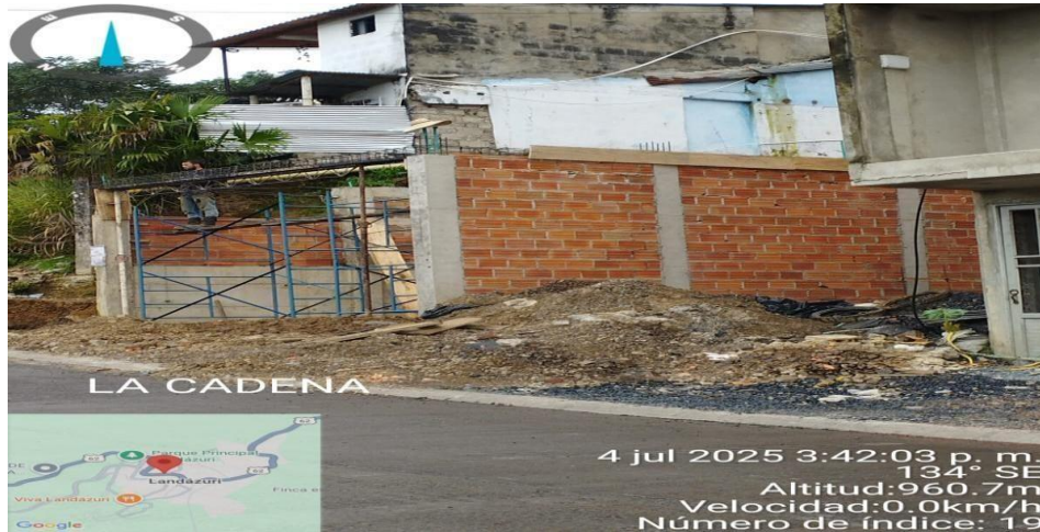
Figura 8. Visita regular obra placa huellas
