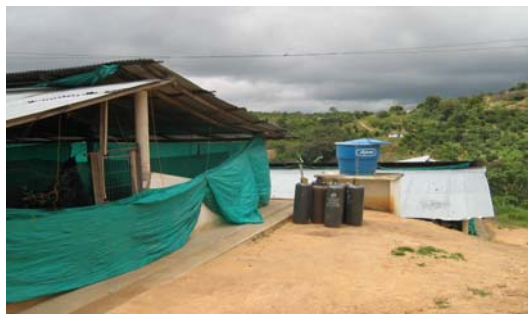
Figura N° 90 Galpón y tanques de tratamiento granja San Juan
