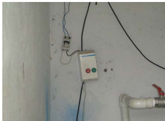
Figura N° 63 Acometida eléctrica motobomba tanques de tratamiento granja San Antonio
