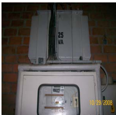
Figura N° 54. Transformador 225 KVA planta de bandejas.
