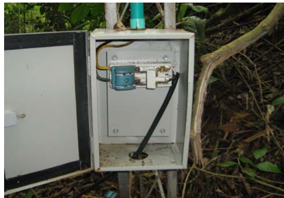
Figura N° 77 Encendido bomba lago granja Abedul
