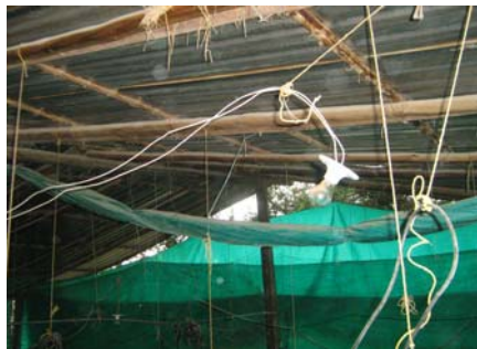
Figura N° 37 Distribución eléctrica galpón granja El portal
