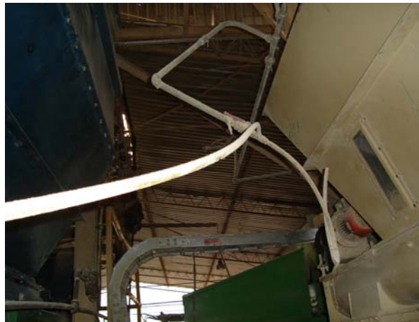
Figura N° 11 Línea neumática hacia raseras de molinos
