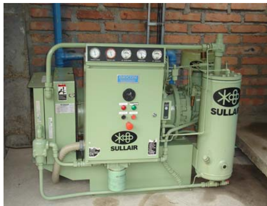
Figura N° 27 Compresor de tornillo
