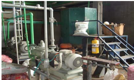
Figura N° 24 Pulper y bombas de vacío
