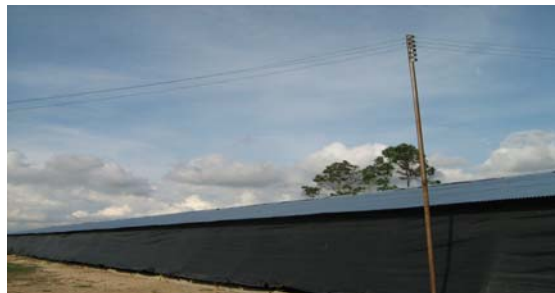
Figura N° 40 Acometida eléctrica a galpones granja Caciquito
