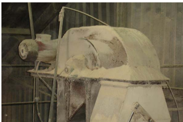
Figura N° 7 Antiguo elevador de harinas
