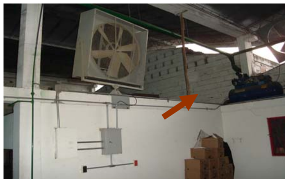
Figura N° 23 Compresor de pistón
