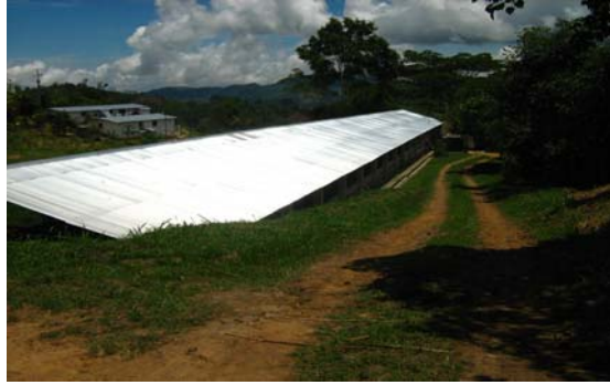
Figura N° 39 Nuevo techo galpón Mesitas
