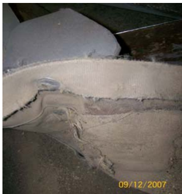
Figura N° 14 Estado de las bandas de elevadores
