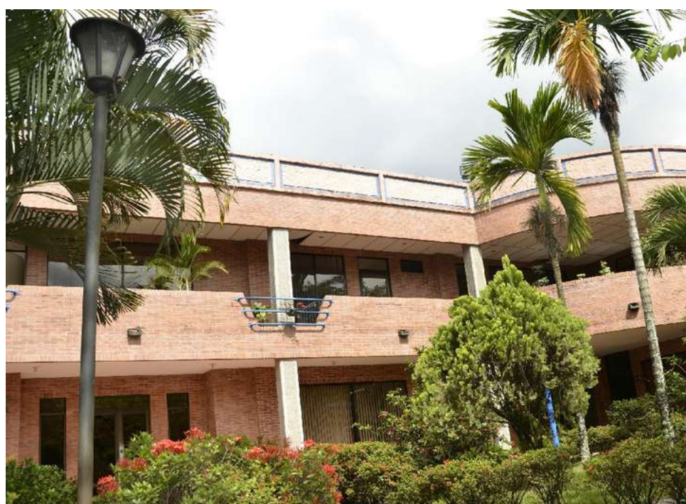
Imagen 2. Fachada de la empresa GRUPO SURTI S.A.S. sede Villavicencio Fuente: www.gruposurti.co
