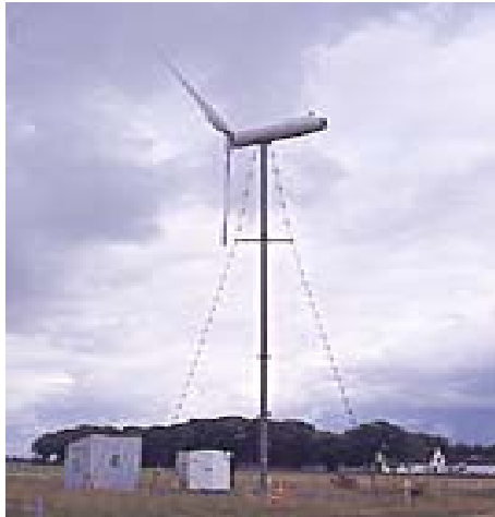
Figura 32. Torre de Mástil
