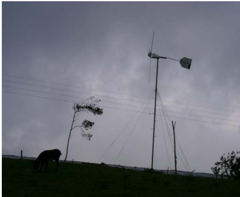
Figura 34. Vegetación en el lugar de emplazamiento.
