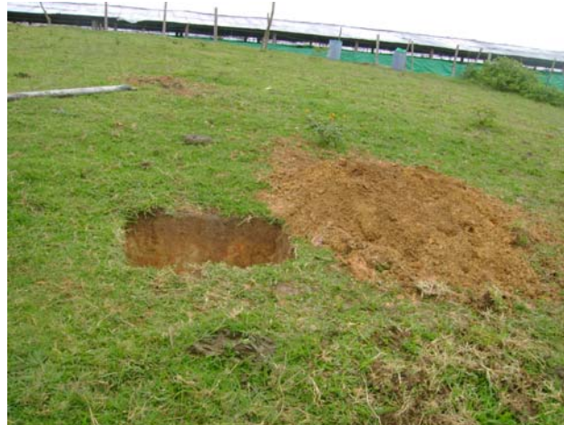
Excavación de la zapata de la torre
