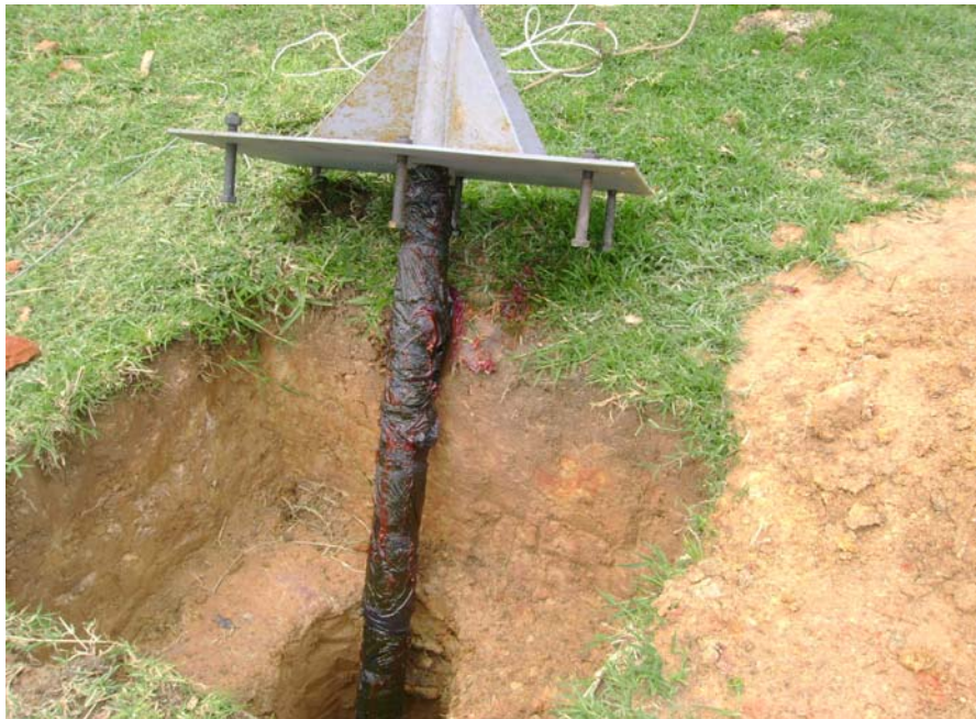
Figura 68. Base de la Torre que va empotrada en la zapata de cimentación.
