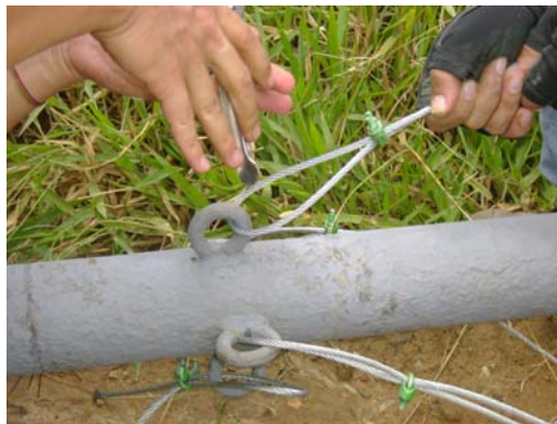
Instalación de los tensores a la altura de 5m de la torre
