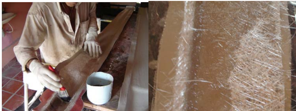
Aplicación de varias capas de fibra y de la emulsión.
