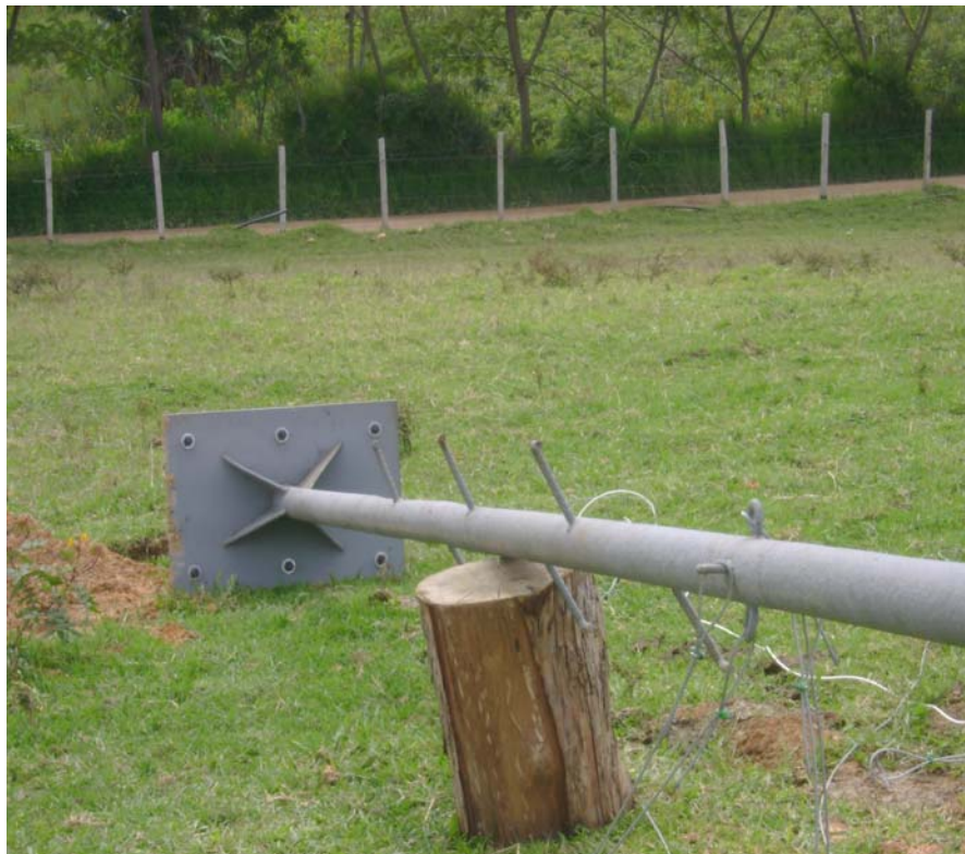
Figura 66. Placa y peldaños de la Torre
