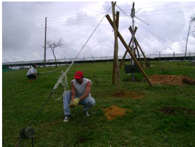
Horqueta. Lazo, tensores y diferencial para elevar la torre
