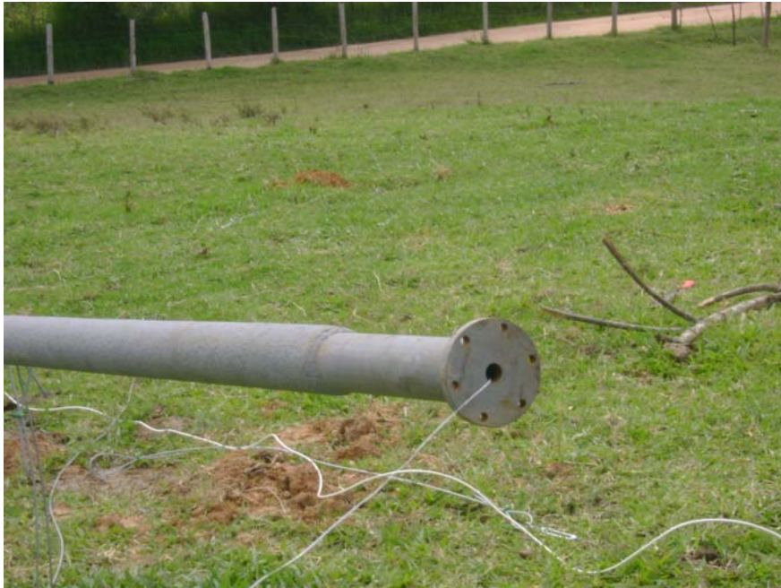
Figura 65. Detalle de la Brida en la parte superior de la Torre
