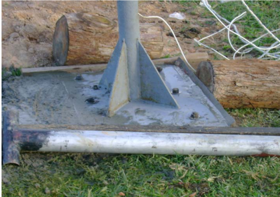
Figura 69. Cimentación de la Torre, secado del concreto.
