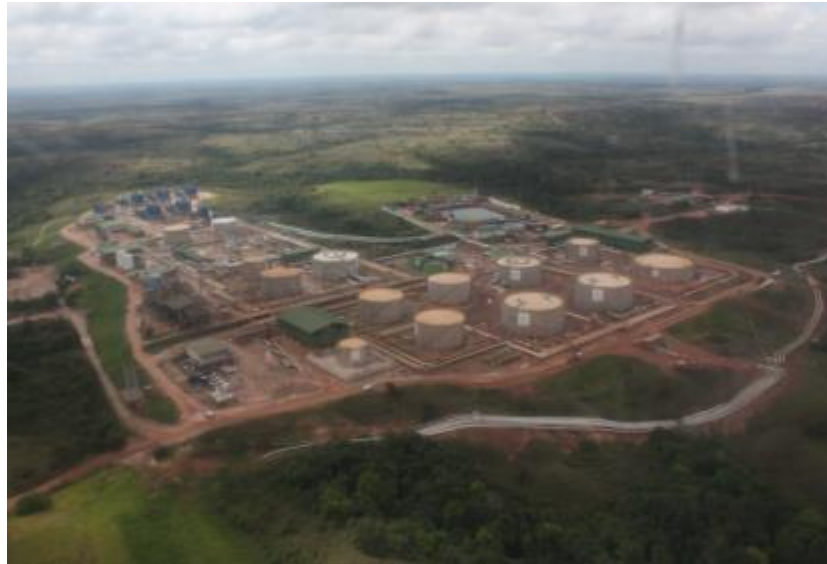
Figura 5. Batería 4 - Proceso Crudo
