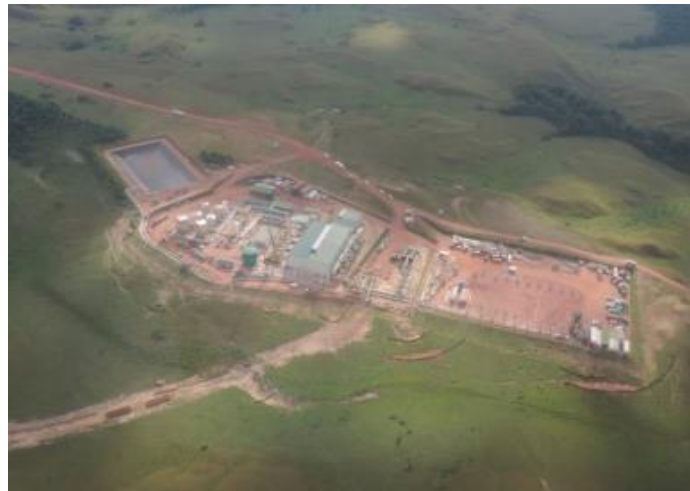
Figura 13. Pad de Inyección
