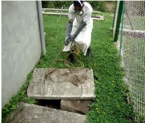
Fotografía 6. Planta de tratamiento de aguas residuales.
