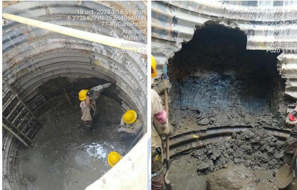
Foto 9. Marcación y excavación portal de inicio para cruce horizontal
