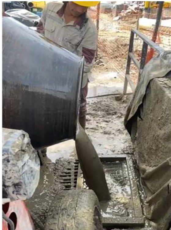
Foto 17. Inyección espacio anular Liner-Tubería
