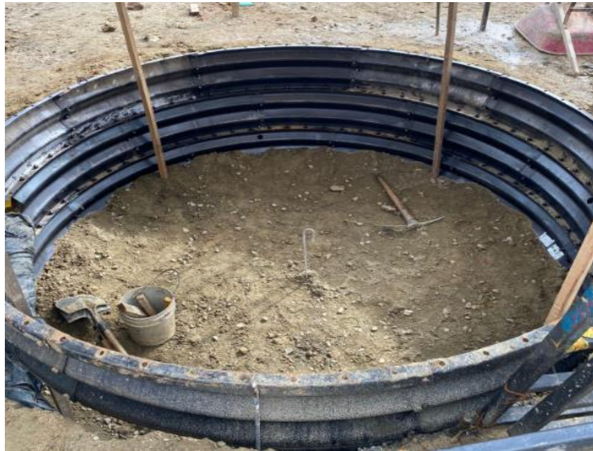
Foto 3. Excavación y armado de anillos
