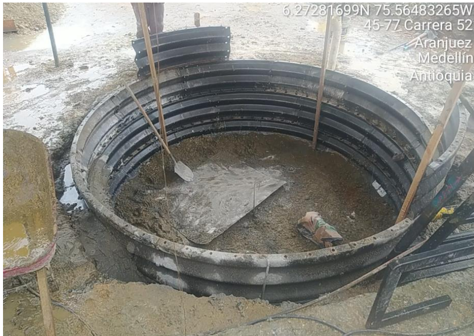
Foto 4. Inyección de mortero fluido para anillos instalados
