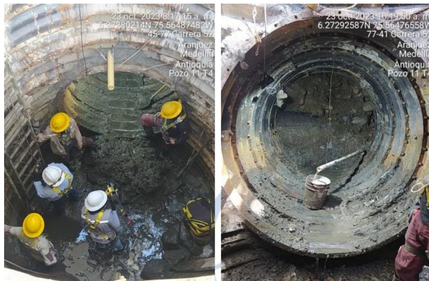
Foto 12. Control topográfico anillos instalados
