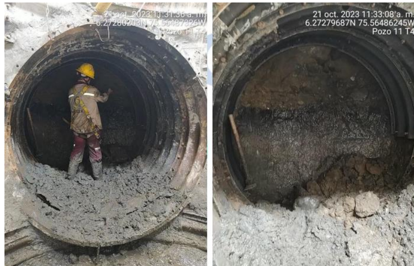
Foto 11. Inyección primeros anillos cruce horizontal
