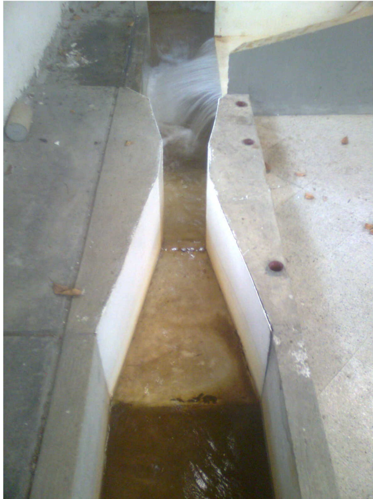
Figura 27 Canaleta Parshall en el canal perimetral
