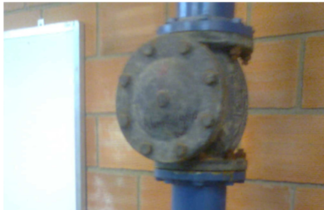
Figura 4 Válvula de retención o cheque
