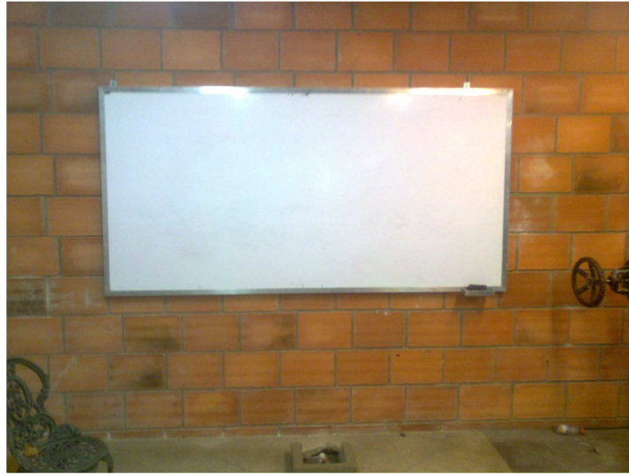
Figura 12 Tablero en acrílico
