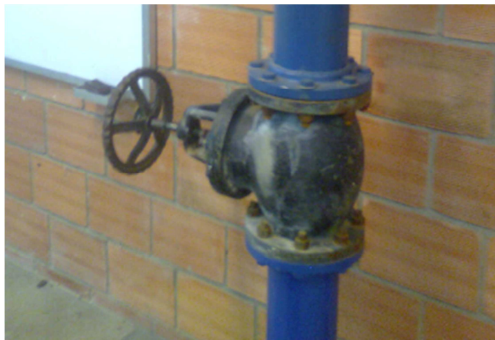
Figura 5 Válvula de globo
