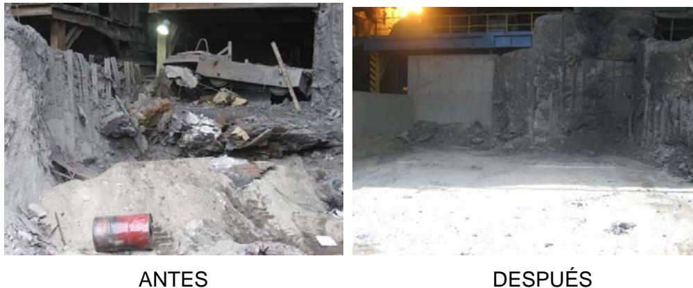
Figura 22. Construcción muro desescoriado.
