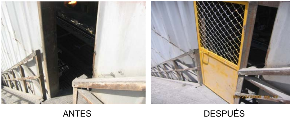
Figura 24. Puerta de acceso a puentes grúa.
