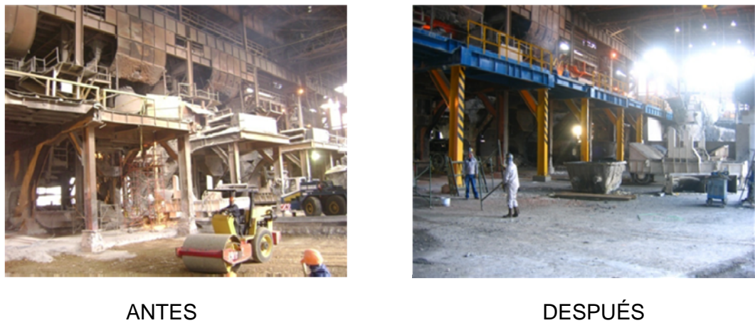
Figura 25. Barandas plataforma segundo nivel convertidores
