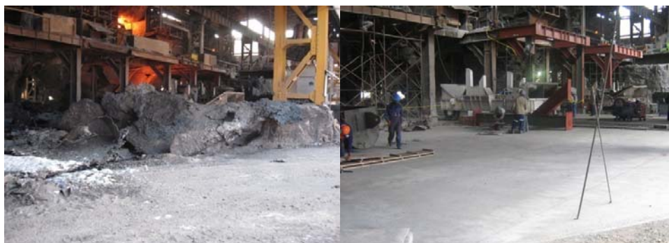
Figura 19. Plataforma y pisos Convertidores
