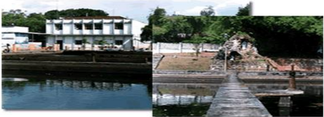
Figura 48. Planta de Tratamiento Morrórico
