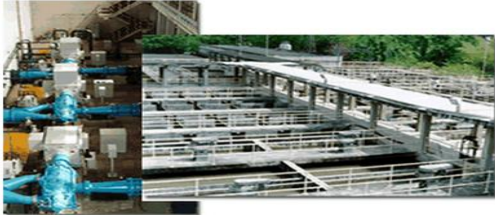
Figura 46. Planta de Tratamiento Bosconia
