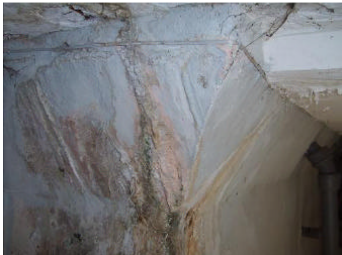
Figura 56. Fisura y deterioro de muro exterior en esquina CD.
