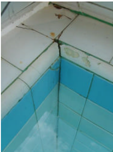
Figura 56. Fisura y deterioro de muro exterior en esquina CD.
