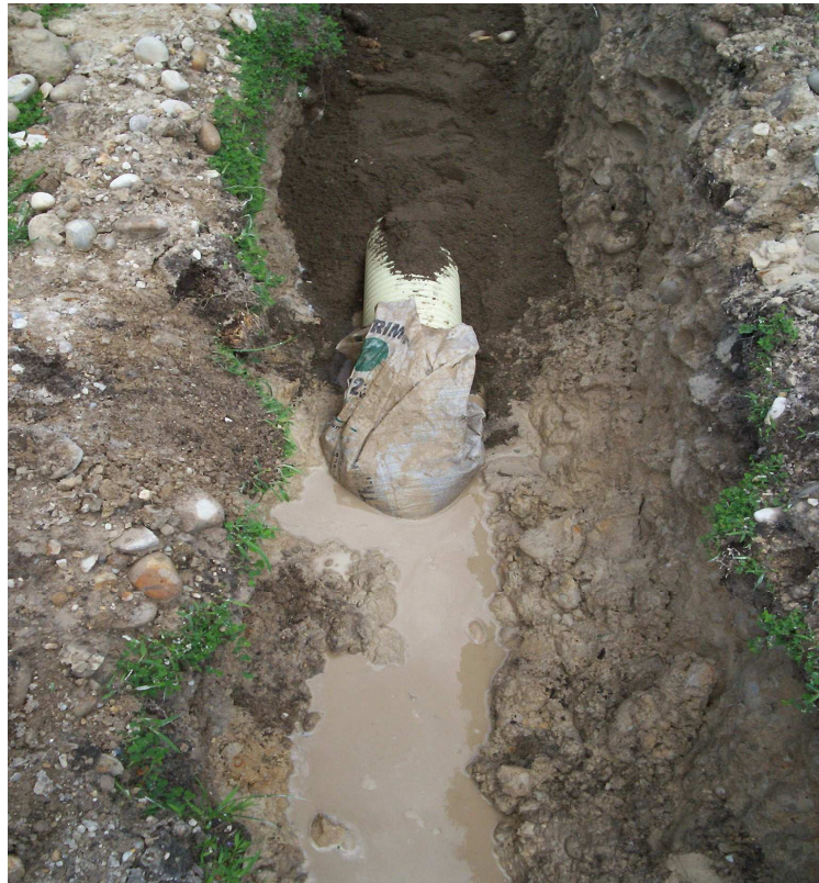
Figura 6. Relleno con material Seleccionado.
