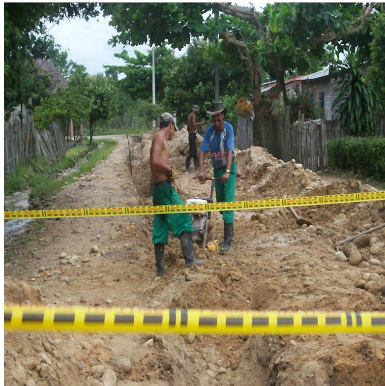
Figura 7. Relleno y compactación con material de sitio
