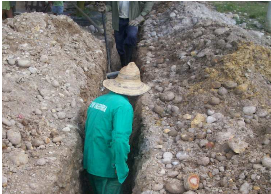
Figura 5. Excavación a mano.
