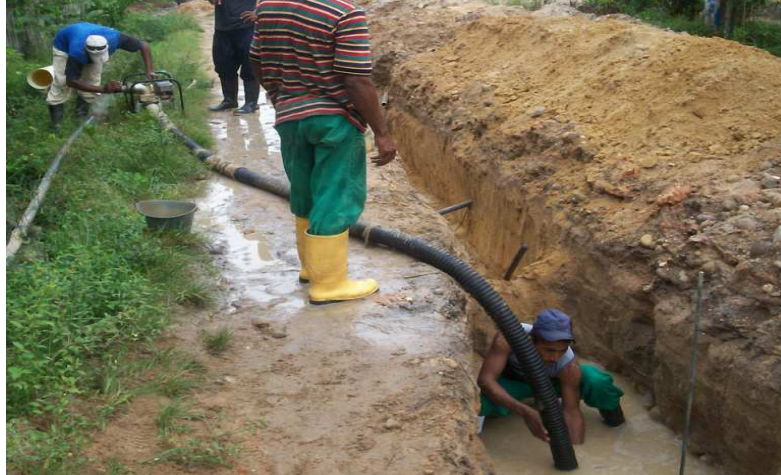
Figura 9. Control de nivel freático y lluvias.
