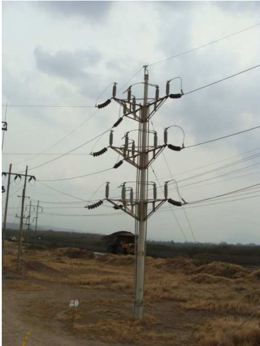
Figura 10. Seccionador de 3 vías
