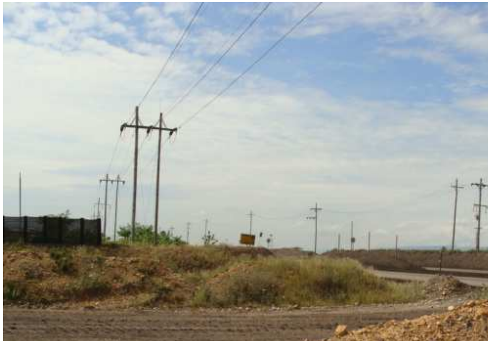
Figura 9. Fotografía tramo de línea Foso sur
