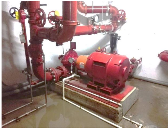
Gráfico 2. Sistema contra incendio Listado UL/FM Bomba Líder de 125 HP
