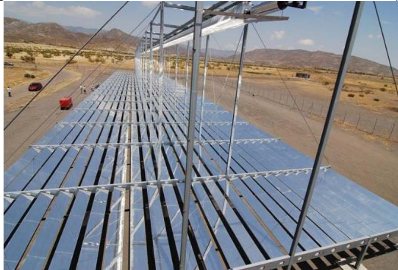
Figura 61. Sistema lineal de Fresnel en la Plataforma Solar de Almería. Tomado de: (35)
