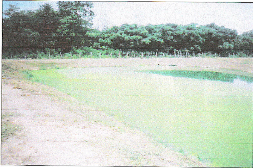
Sitio de tratamiento de aguas residuales - Laguna de oxidación
