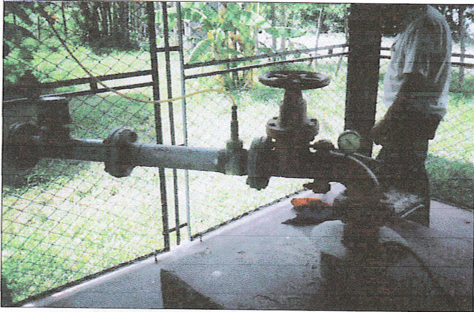
Sitio de captación - pozo perforado en regular estado
