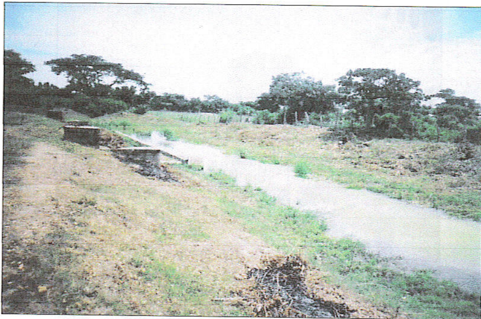
Canal de vertimiento final hacia el arroyo
