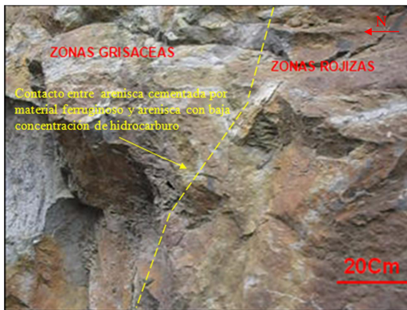
Figura 30. Se observan las dos tonalidades indicadoras. Zona grisácea bajo contenido de hidrocarburo, zona Rojiza alto contenido de cemento ferruginoso.
