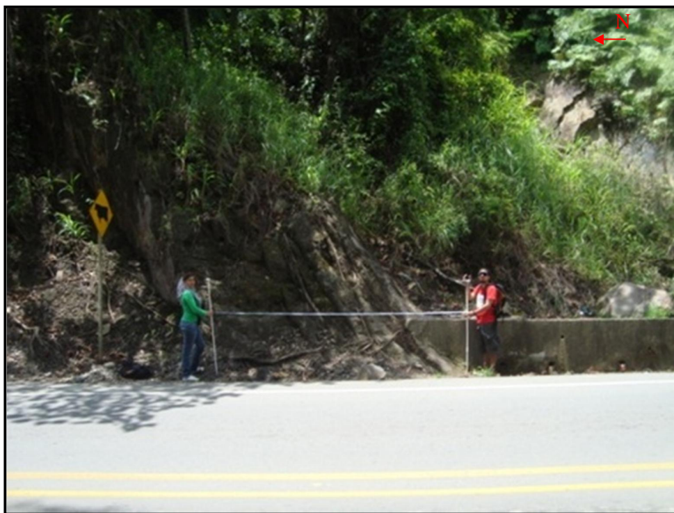
Figura 11. Poligonal Realizada en campo, vía Bucaramanga-Barrancabermeja, sector "La Fortuna".
