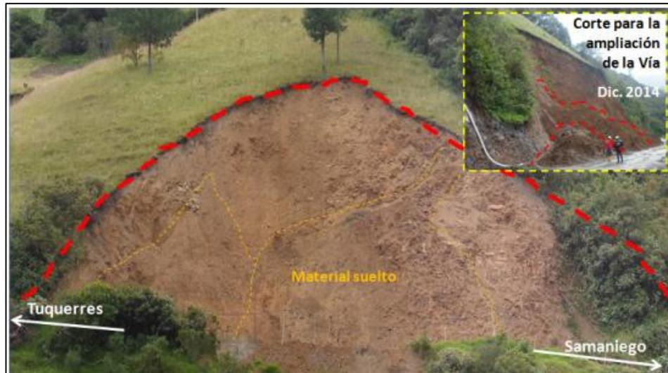
Figura 16. Área de Afectación de la Vía producto del corte de Talud KM17+850
