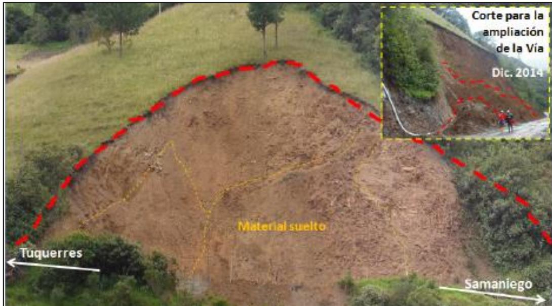
Figura 3. Área de afectación de la vía producto del corte.
