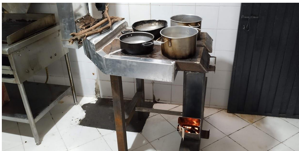
Figura 33. Puesta en marcha para observar la existencia de posibles fugas.
