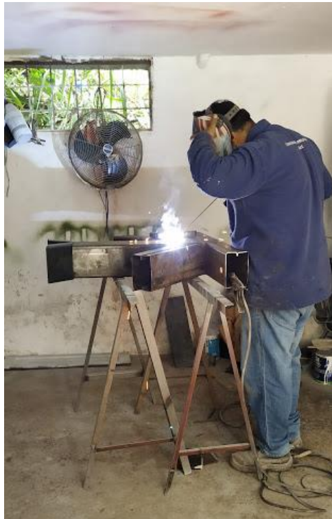
Figura 25. Soldadura para la unión de los segmentos que hacen parte del hogar.
