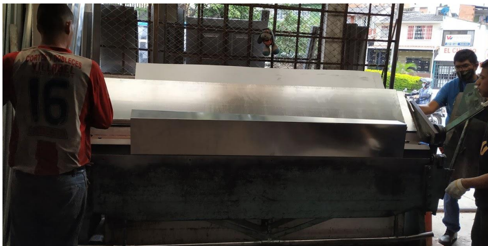
Figura 28. Doblado de lámina para la obtención de la chimenea.
