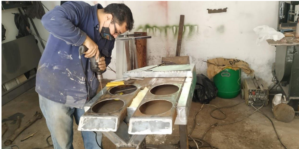
Figura 31. Instalación del aislante alrededor de los ductos.
