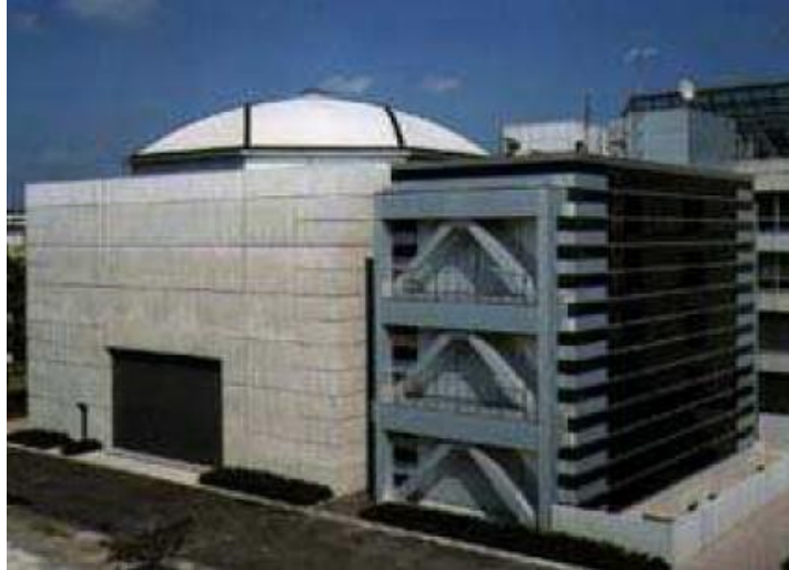
Figura 3. Edificio de control del instituto de Investigación Técnica de Kajima
