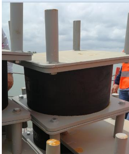
Figura 6. Aislador elastomérico con núcleo central de plomo en forma cilíndrica (Apoyo LRB).
