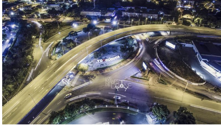
Figura 22. . Puente sobre la redoma San Mateo
