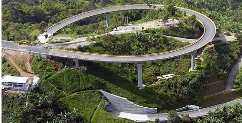
Figura 23. Viaducto Helicoidal, Pereira.
