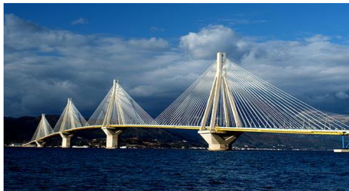
Figura 18. Puente Rion Antirion.
