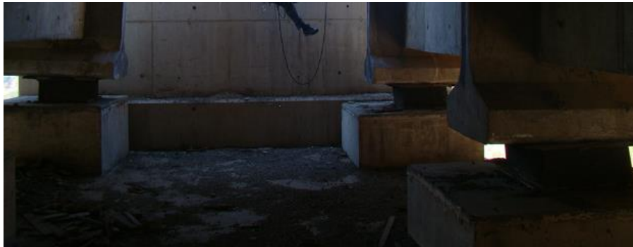
Figura 14. Aisladores de goma de alto amortiguamiento con placas metálicas.
