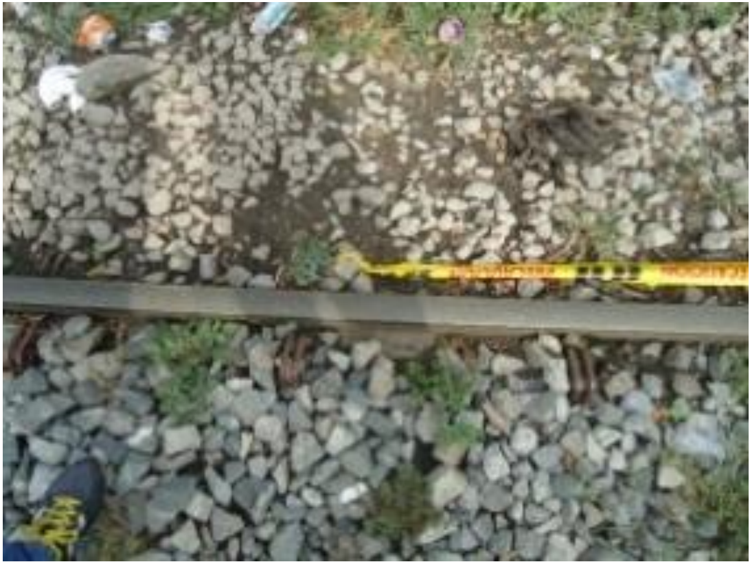
Figura 1. K0+000, Estación Barrancabermeja.
