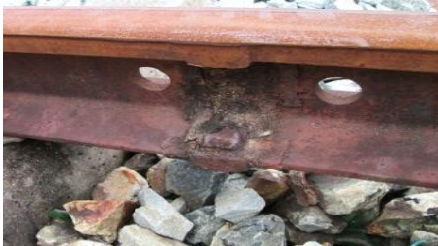
Figura 13. Soldadura Aluminotérmica.
