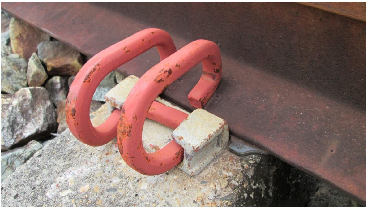
Sujeción tipo pandrol
