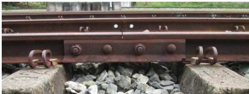
Figura 12. Brida, junta de riel.
