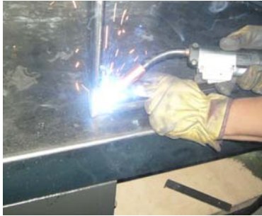
Figura 121. Proceso de soldado estructura – Hablador
