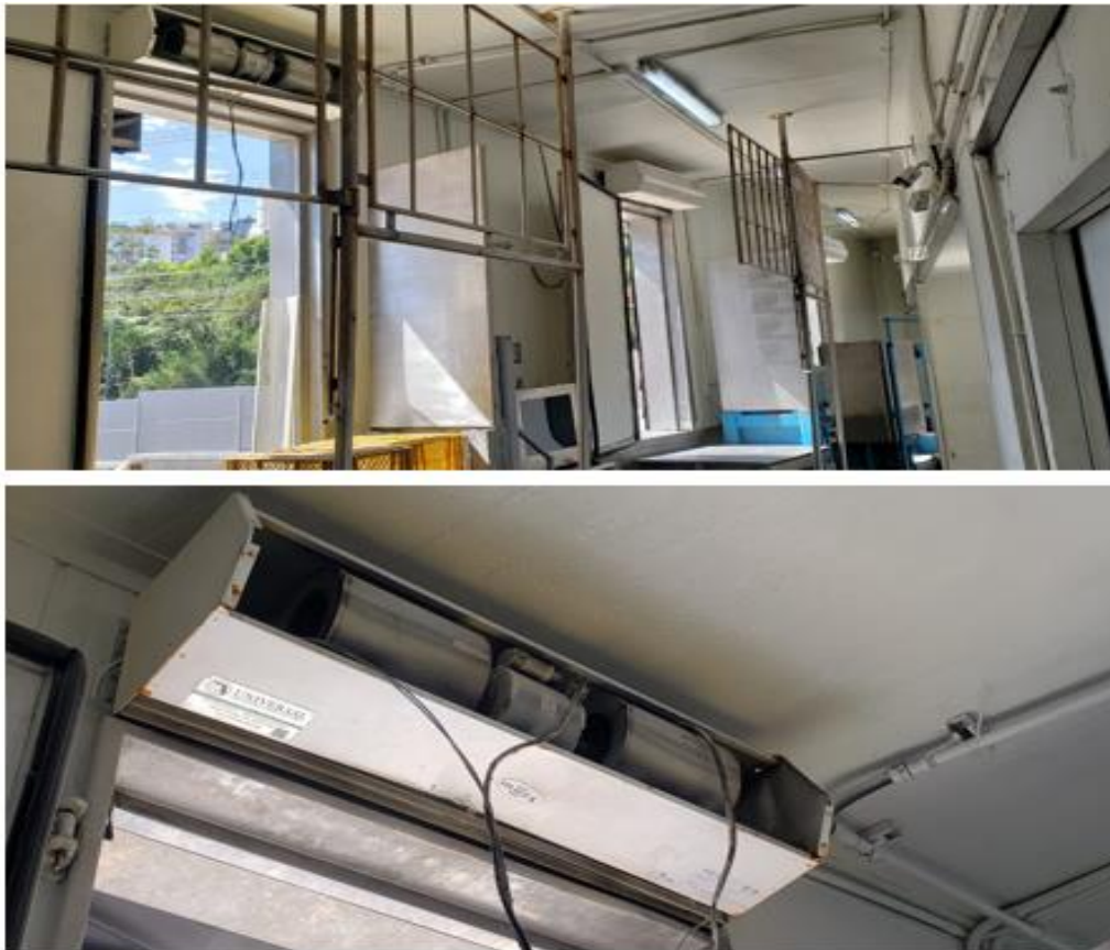
Figura 61. Instalación de cortinas de aire en zona de despacho del producto
