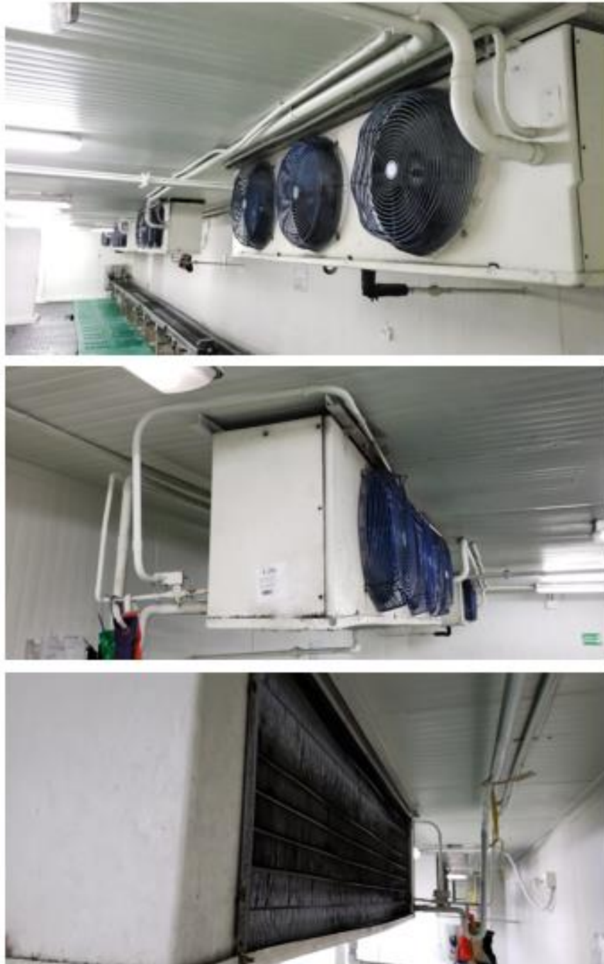
Figura 26. Unidades evaporadoras.
