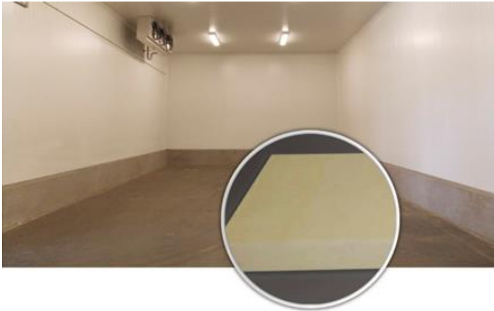
Figura 6. Cuarto frío y sección de panel en poliuretano. }
