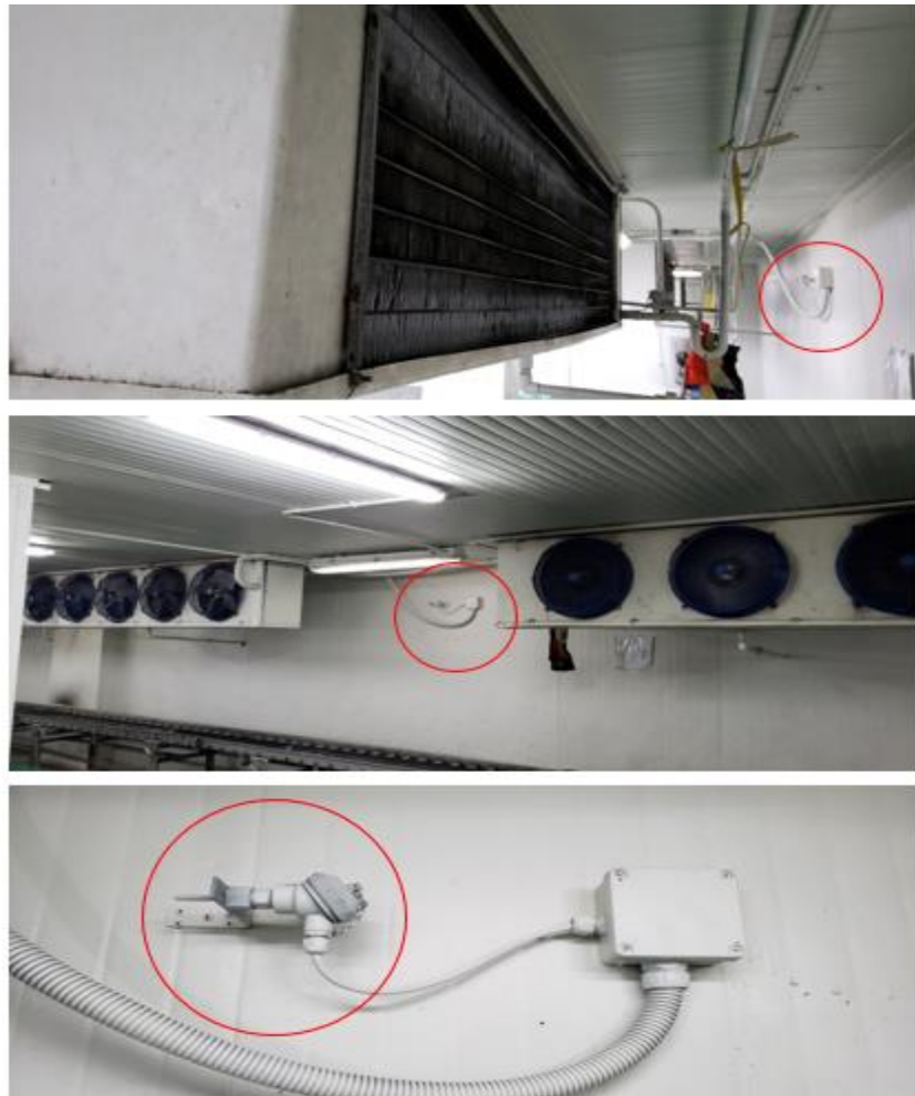
Figura 53. Instalación PT-100 número 3.
