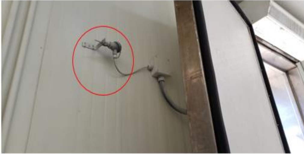
Figura 56. Instalación de PT-100 puertas de despacho
