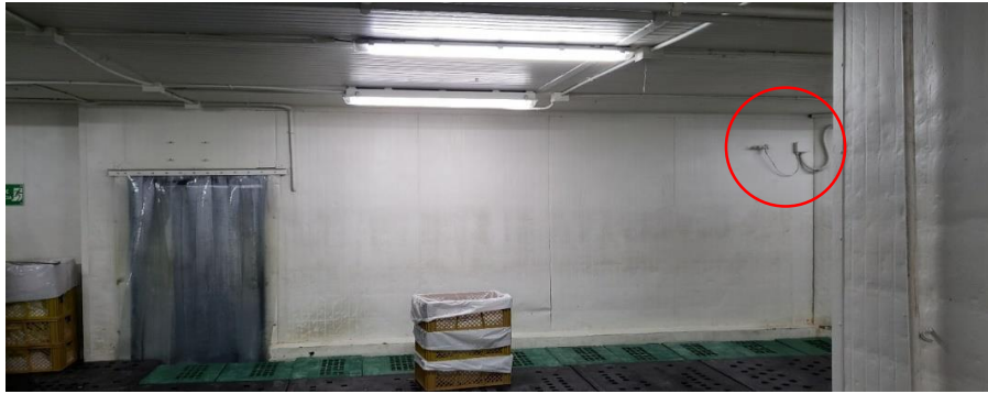
Figura 54. Instalación PT-100 en pared de cámara número 5
