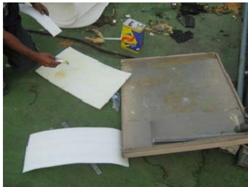
Figura 70. Cambio del aislamiento térmico de la condensadora.
