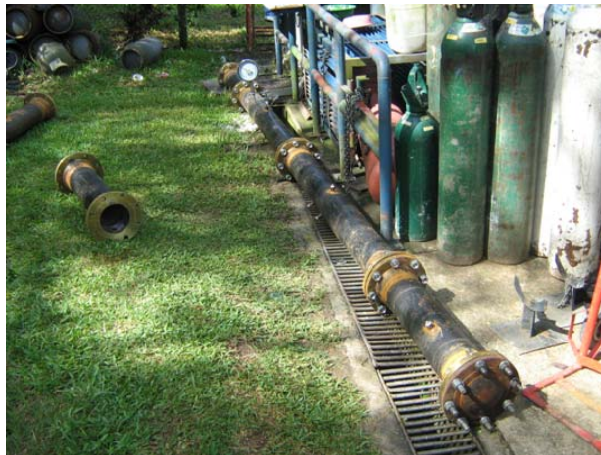
Figura 96. Montaje de prueba hidrostática.
