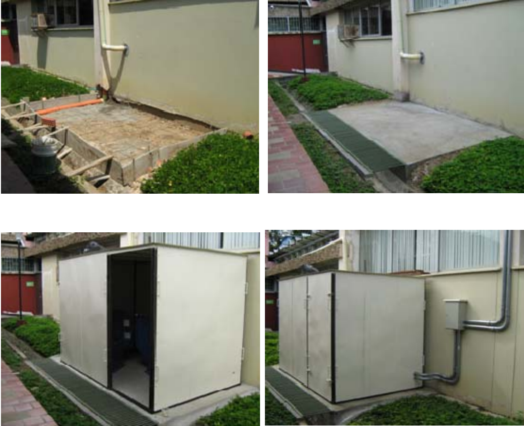
Figura 90. Cimentación de placa e instalación de cuarto para Blowers.
