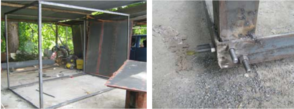
Figura 89. Construcción Cuarto de maquinas.
