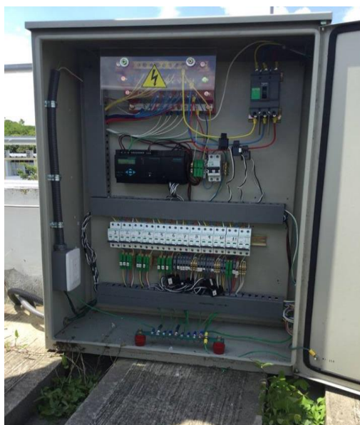
Figura 12. Tablero 1 de la terraza del sexto piso.
