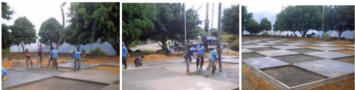
Foto 13. Vaciado y curado del concreto
