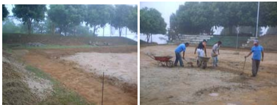
Foto 15. Movimiento de tierras para la construcción de la cancha de voleibol
