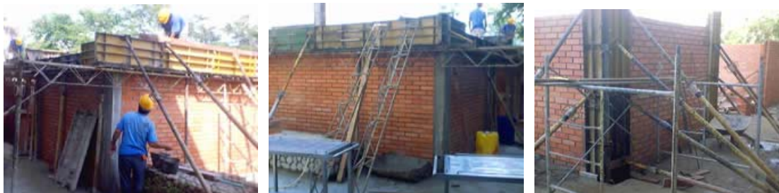
Foto 4. Armado y fundición de columnas
