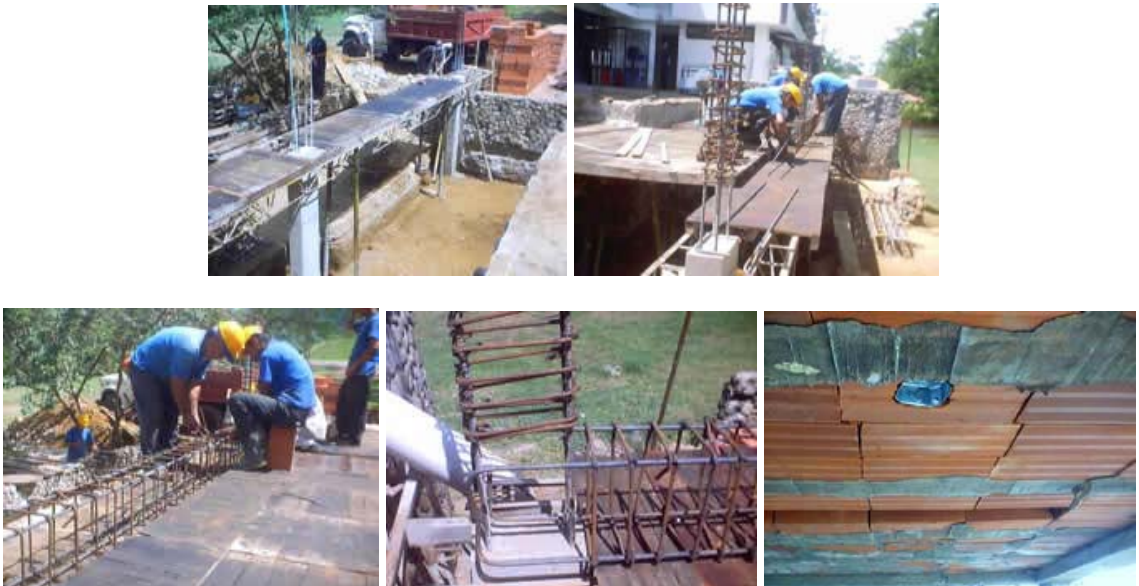
Foto 3. Construcción de la placa aligerada
