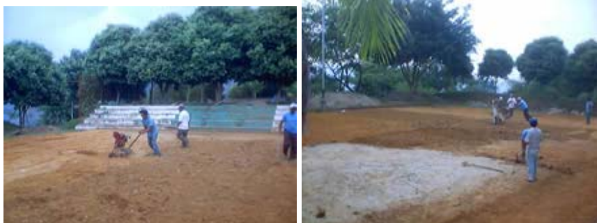
Foto 16. Compactación del terreno
