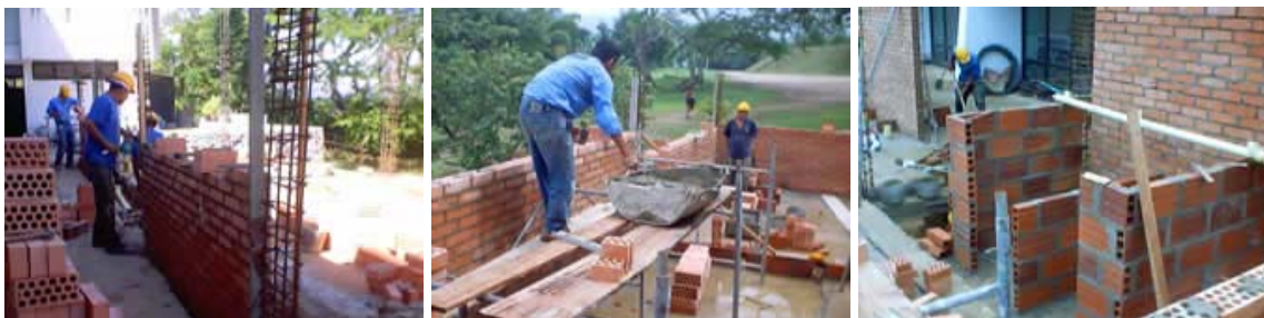
Foto 5. Muro de mampostería
