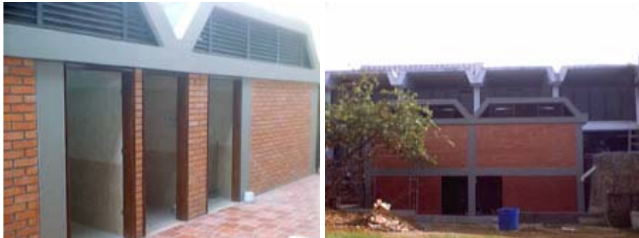
Foto 1. Nueva batería de baños para el servicio de comedores
