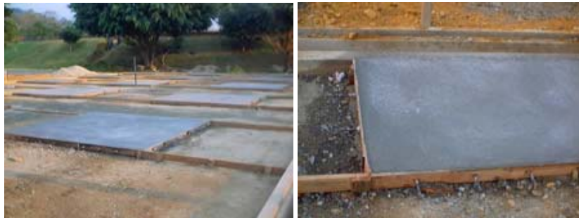
Foto 12. Esquema de fundición de losas
