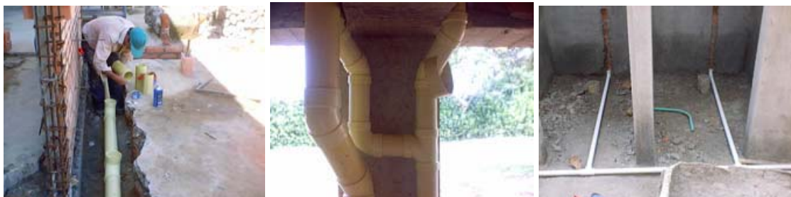
Foto 6. Instalación de tubería sanitaria e hidráulica
