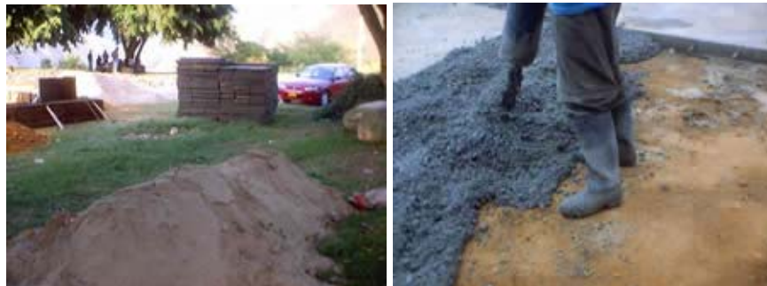
Foto 8. Algunos materiales empleados en la obra
