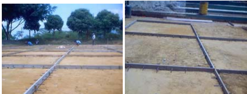
Foto 17. Instalación de formaleta para fundición de la superficie de la cancha
