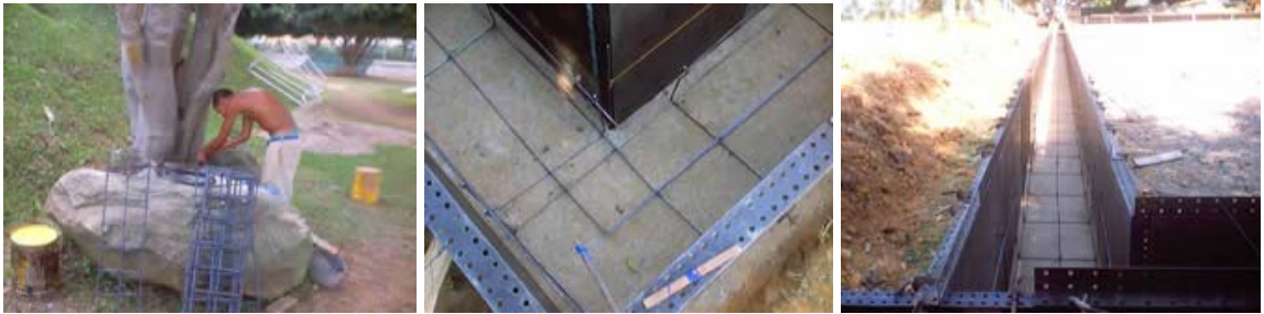
Foto 9. Detalle canaleta perimetral
