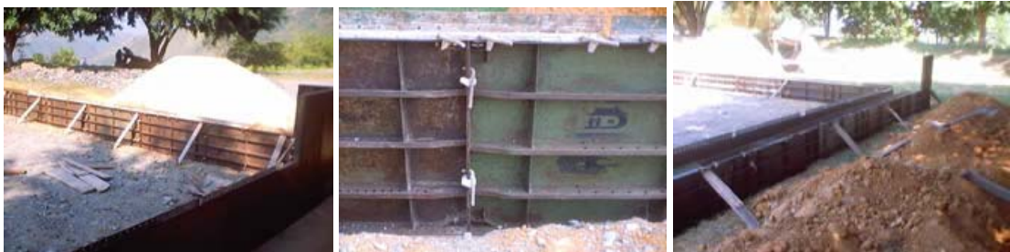
Foto 10. Armado de formaleta
