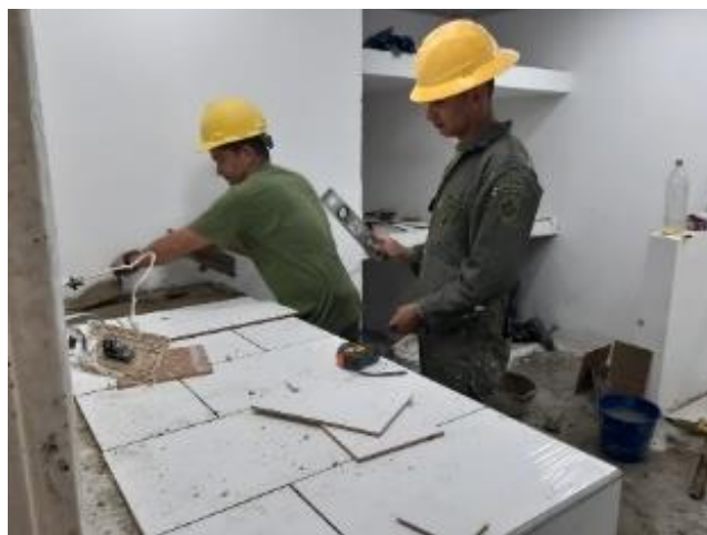
Figura 26. Control de obra, fase enchape mesones
