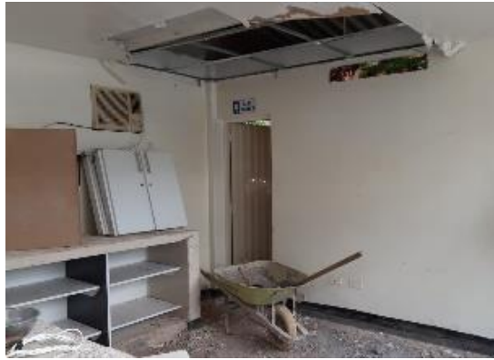
Figura 19. Control de obra, pase desmonte de estructuras.
