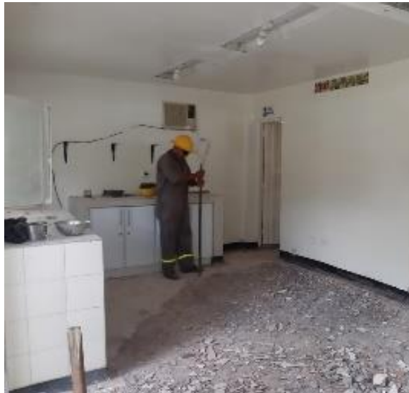
Figura 18. Control de obra, fase demolición.
