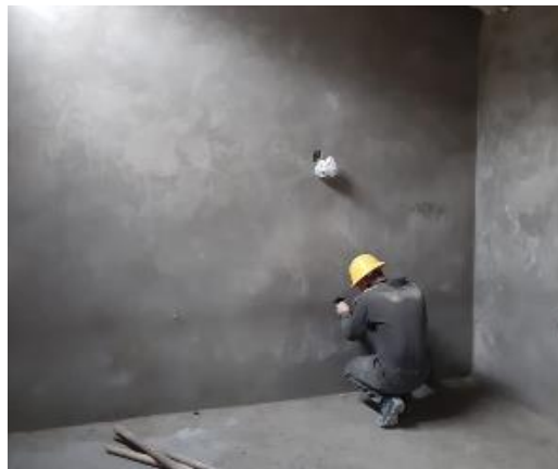
Figura 22. Control de obra, fase mortero y pañete.
