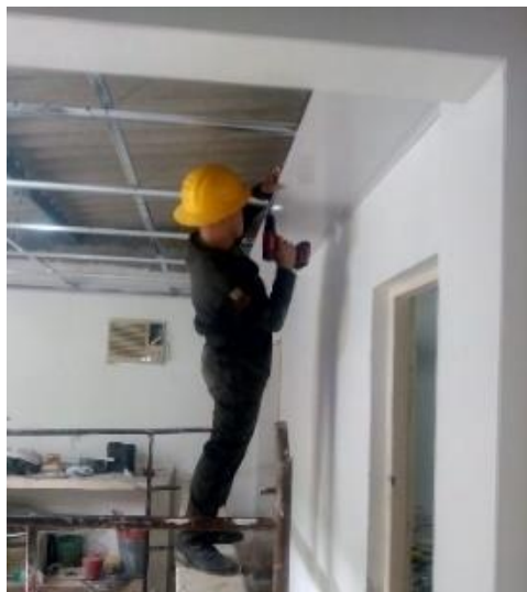
Figura 23. Control de obra, fase estuco, cielo raso e instalación eléctrica.
