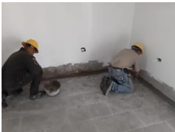
Figura 25. Control de obra, fase media caña
