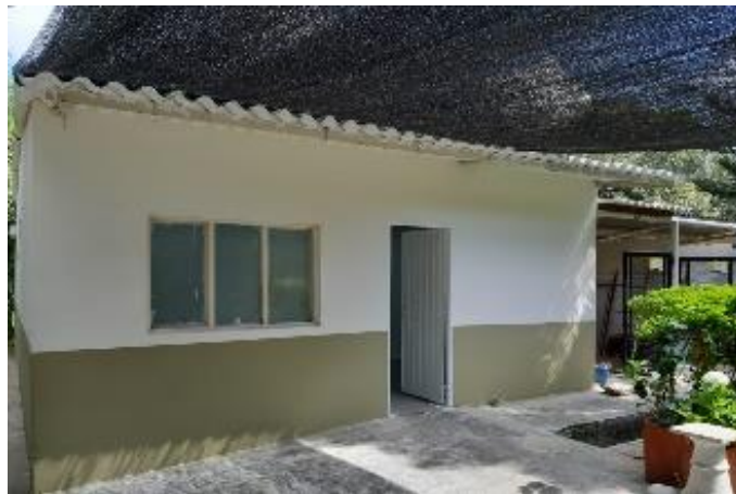
Figura 28. Control de obra, fase final.
