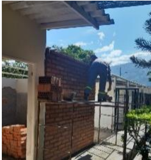
Figura 21. Control de obra, fase muros.
