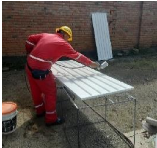
Figura 27. Control de obra, fase pintura.
