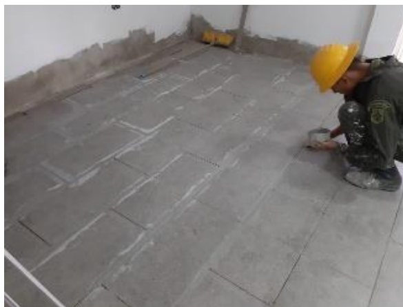
Figura 24. Control de obra, fase enchape
